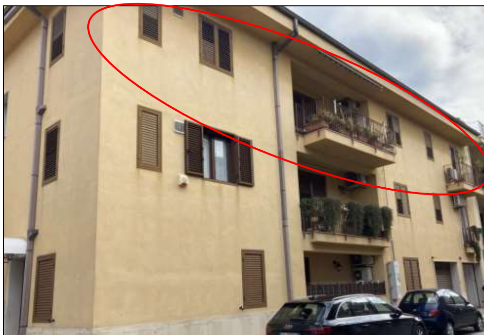
Foto n. 2 – Prospetto su Via Concetto Marchesi
