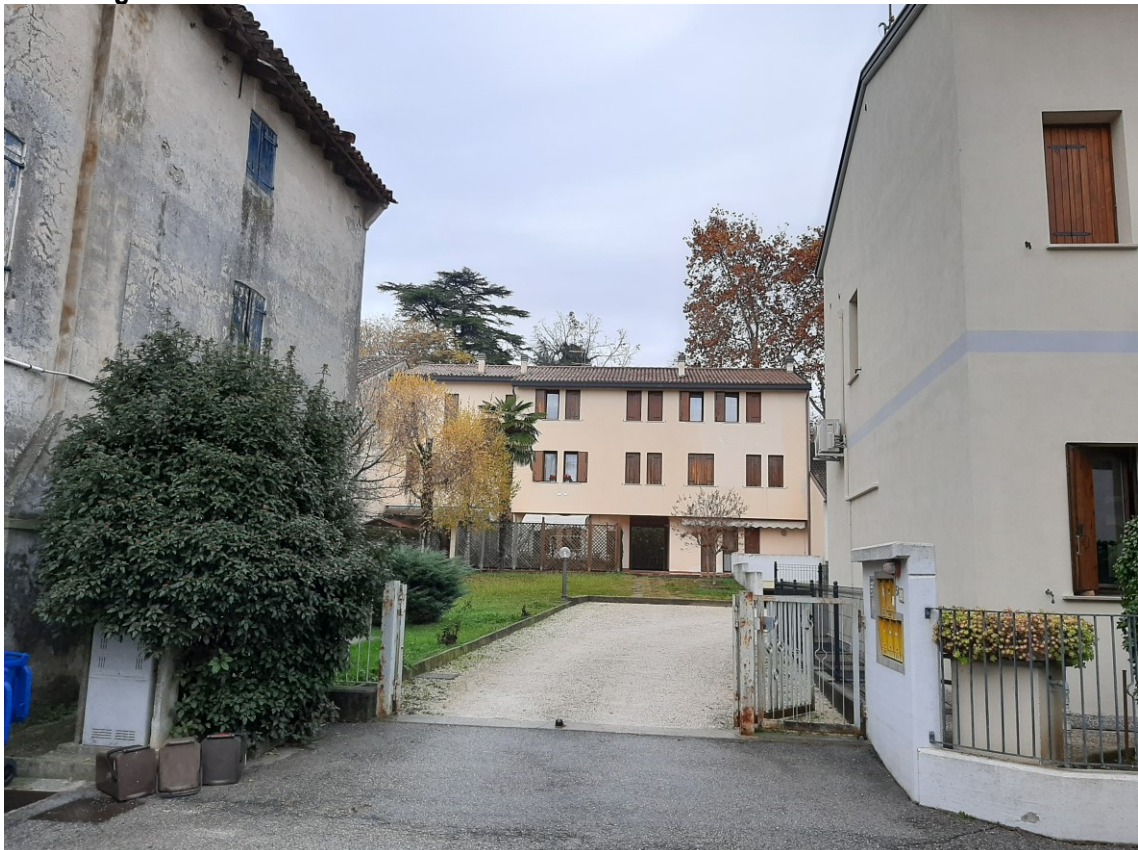
Fig. 13 – vista da sud dell'accesso all'immobile dal ramo di via Schiavonesca
