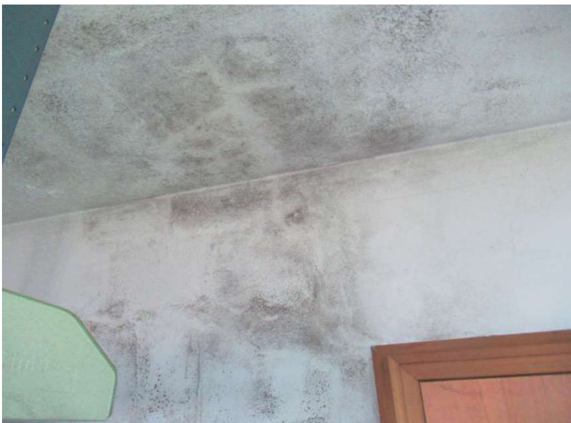
Foto 28: Infiltrazioni copertura
