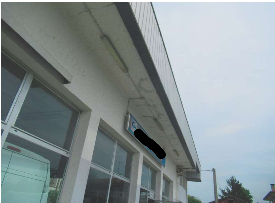
Foto 5: Infiltrazione copertura
