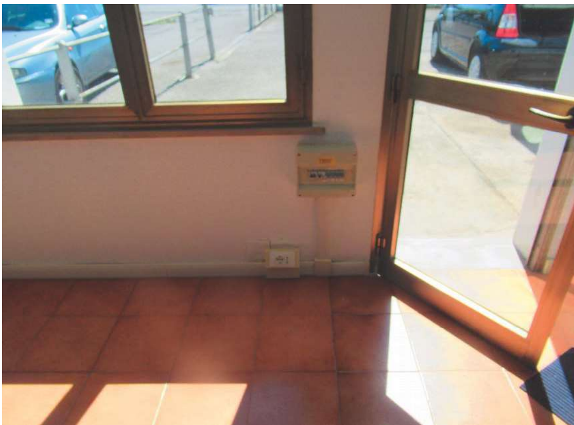
Foto 17: Particolare serramenti magazzino
