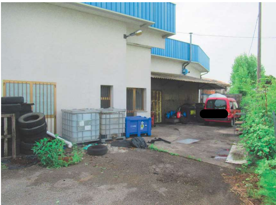
Foto 10: Autofficina vista da Ovest
