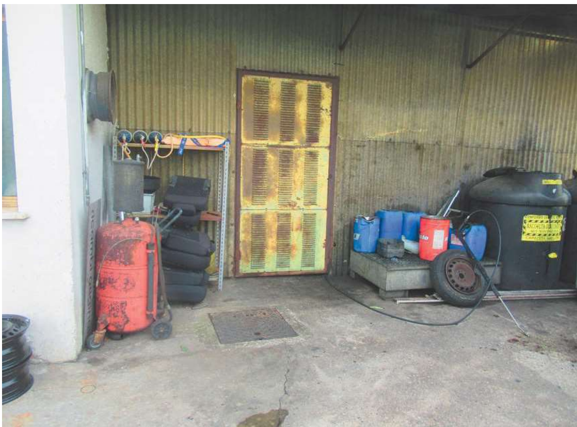
Foto 12: Parete esterna ripostiglio in plexiglass
