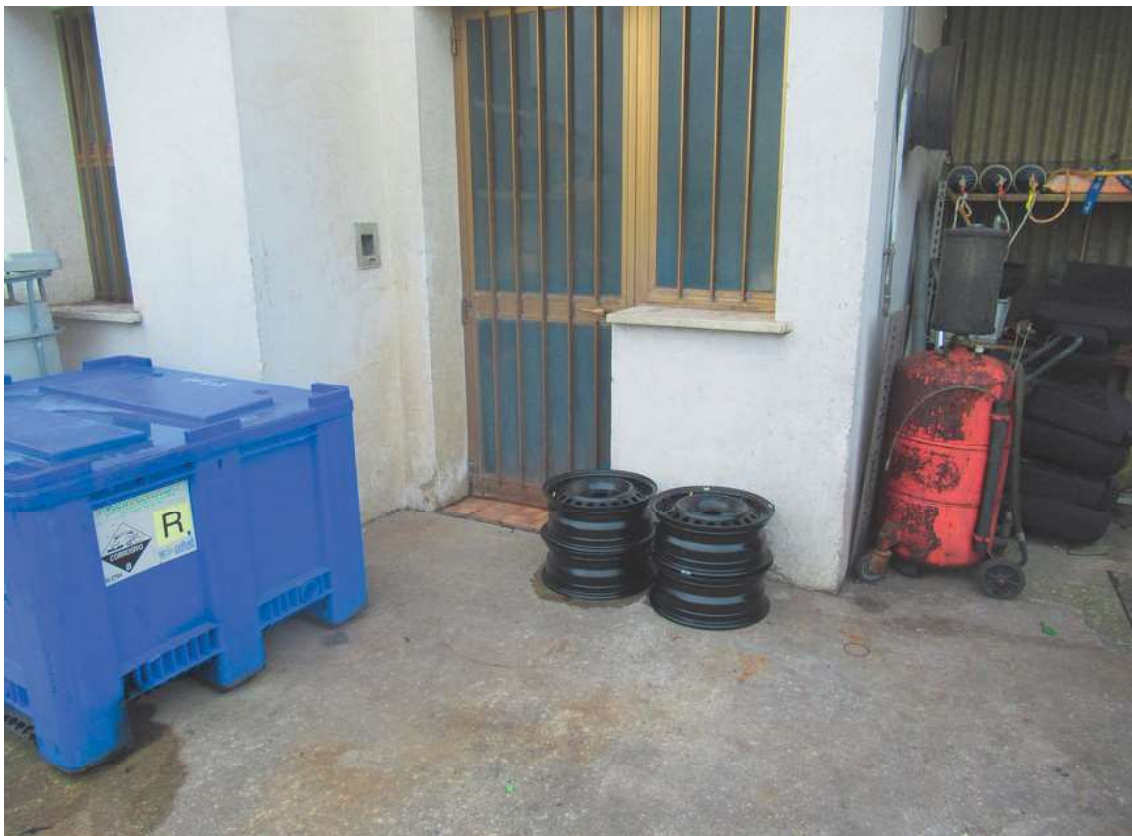
Foto 11: Porta finestra spogliatoio
