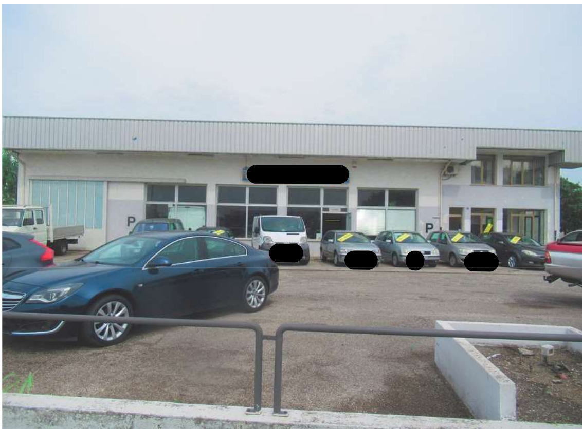
Foto 1: Prospetto Sud-Est autofficina
