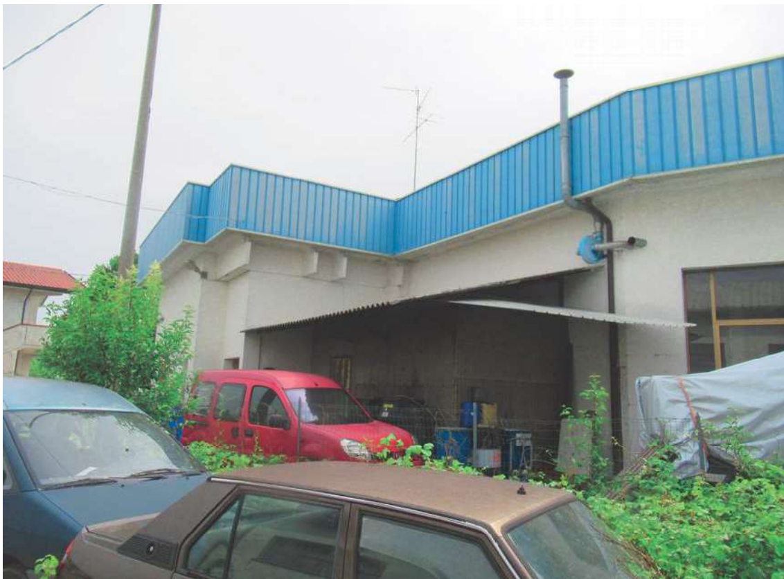
Foto 13: Autofficina vista da Sud-Ovest
