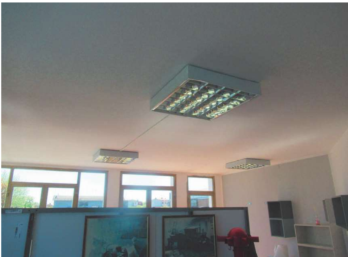
Foto 16: Magazzino piano terra
