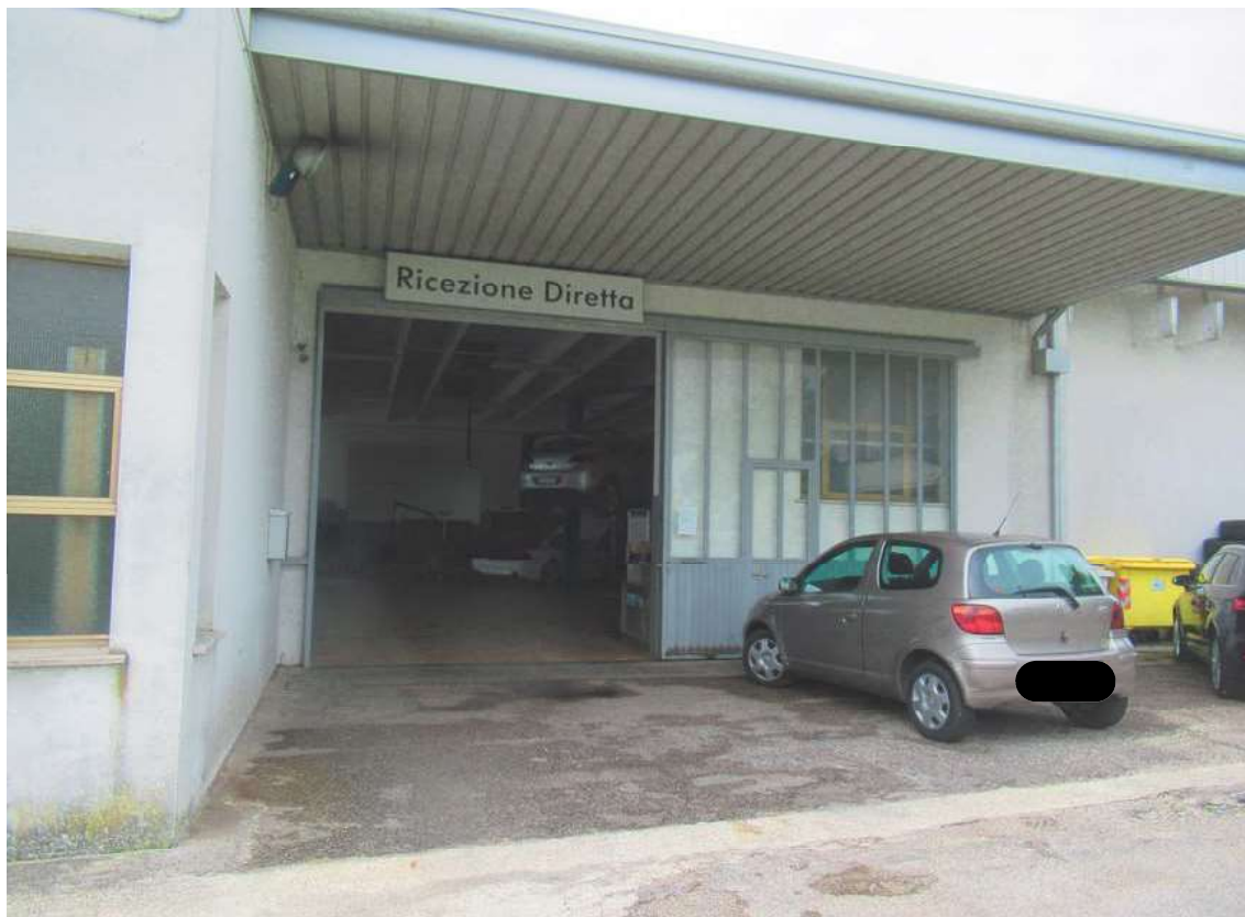
Foto 6: Ingresso Nord officina
