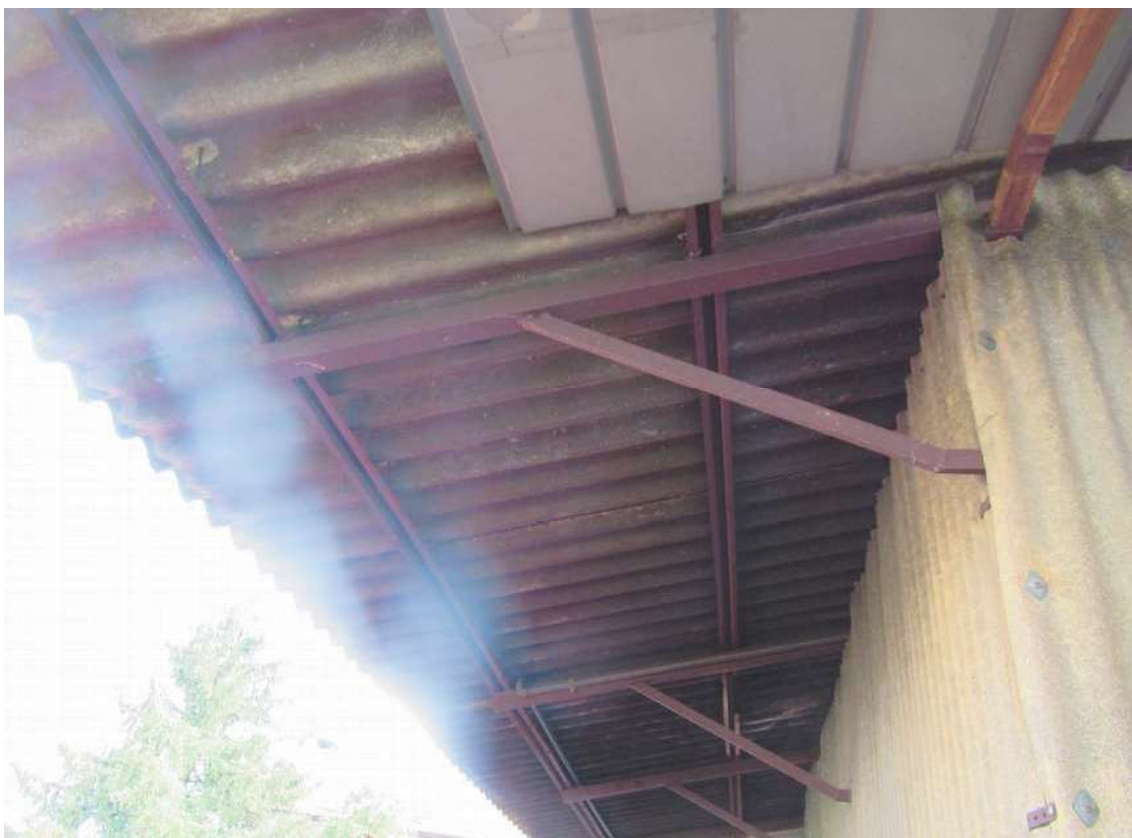
Foto 14: Tetto ripostiglio in eternit
