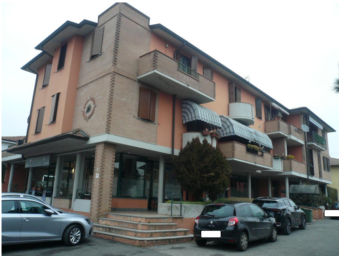
Figura 3 - Vista dalla strada pubblica del fabbricato in cui è ubicato il bene oggetto di stima
