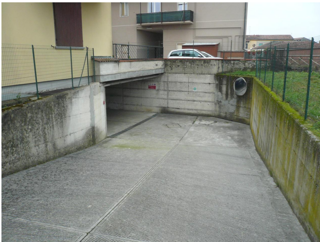
Figura 5 - Particolare rampa di accesso al piano autorimesse
