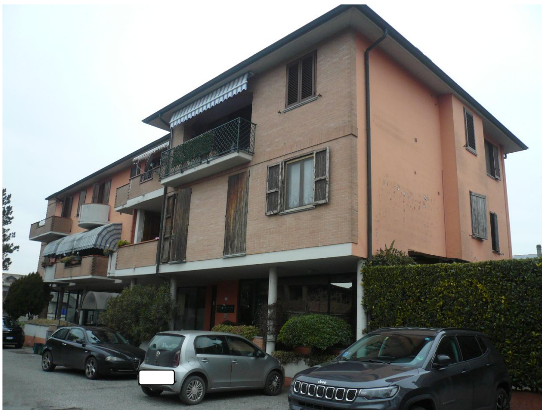
Figura 1 - Vista dalla strada pubblica del fabbricato in cui è ubicato il bene oggetto di stima
