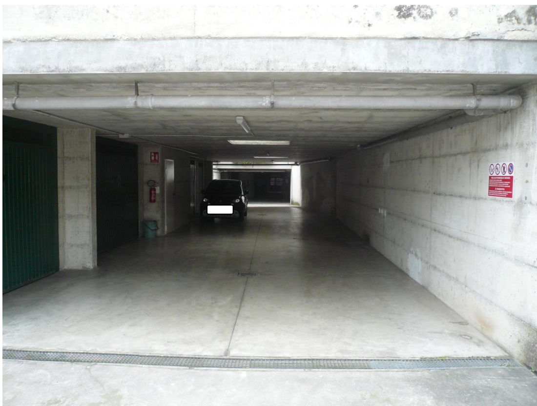
Figura 6 - Particolare corsello box comune
