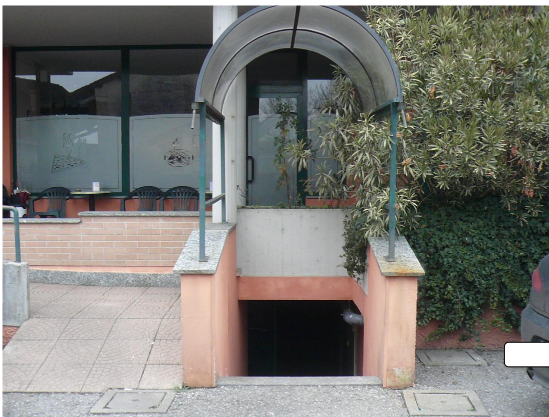
Figura 2 - Particolare ingresso pedonale al piano autorimesse
