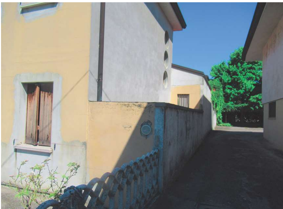
Foto 4: Abitazione vista da Sud-Est
