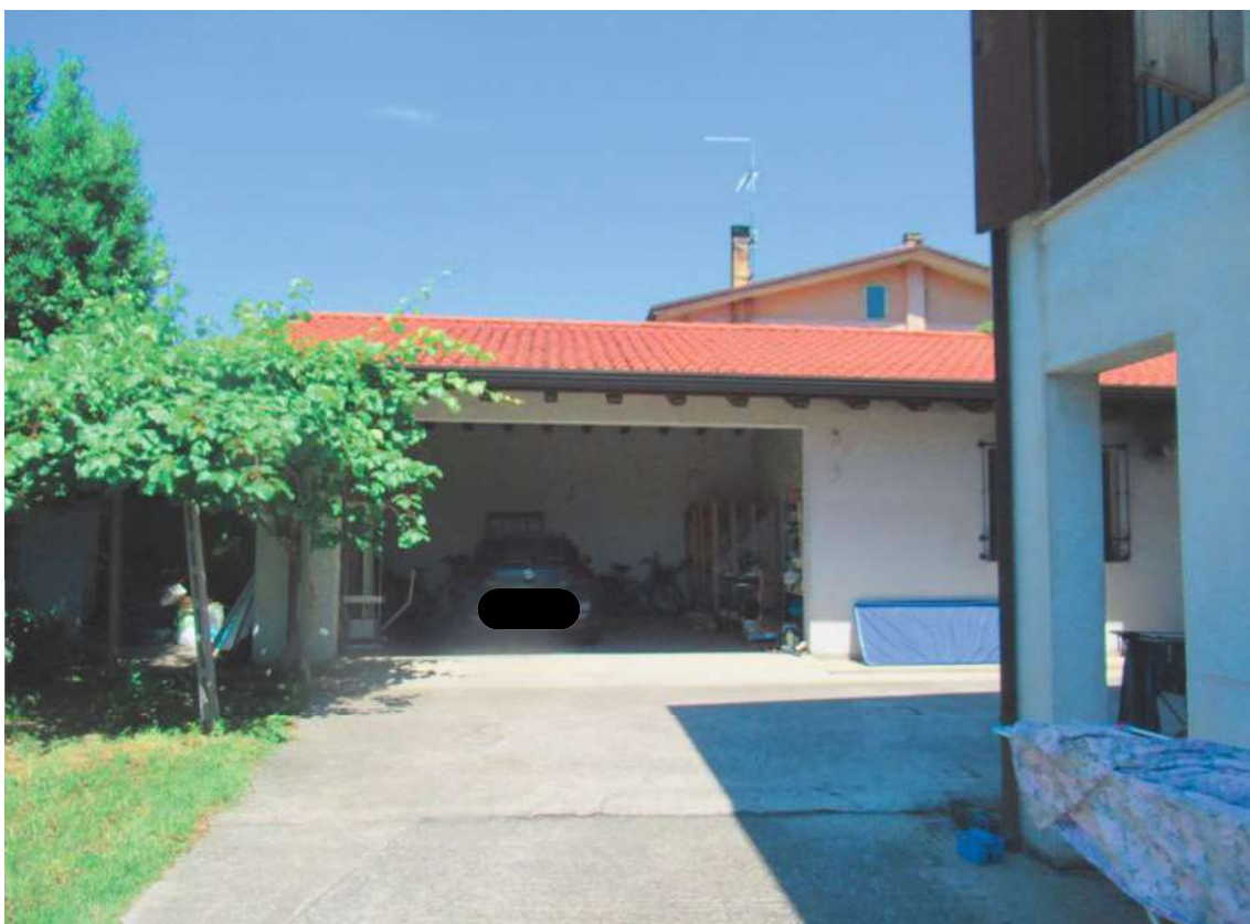
Foto 11: Accesso carrabile accessorio visto prima dell'installazione dei pannelli fotovoltaici e solari
