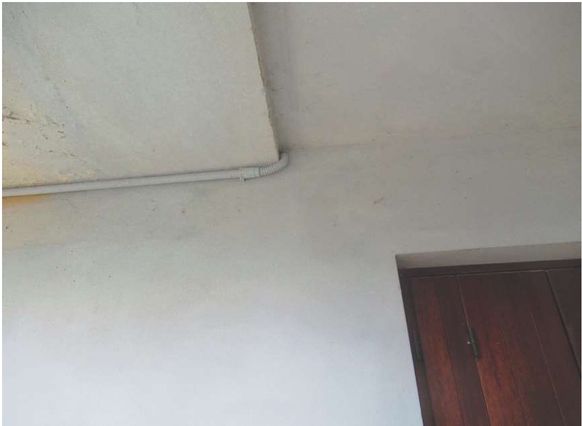
Foto 15: Particolare ingresso collegamento fotovoltaico all'abitazione
