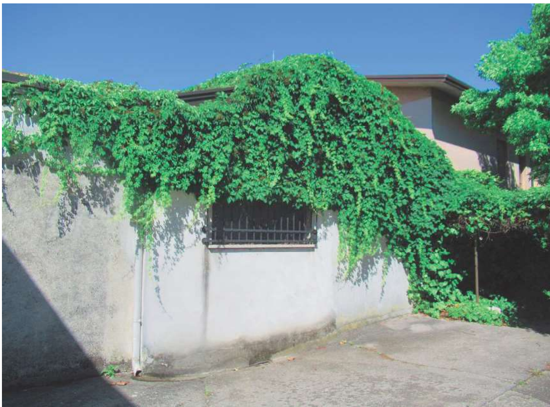
Foto 7: Parete a confine accessorio mapp. 325
