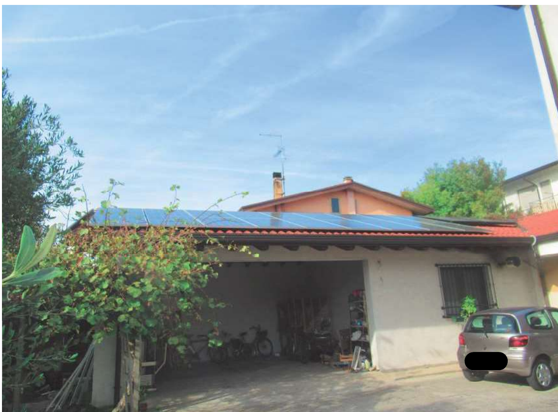
Foto 12: Accessorio mapp. 325 con fotovoltaico e solare
