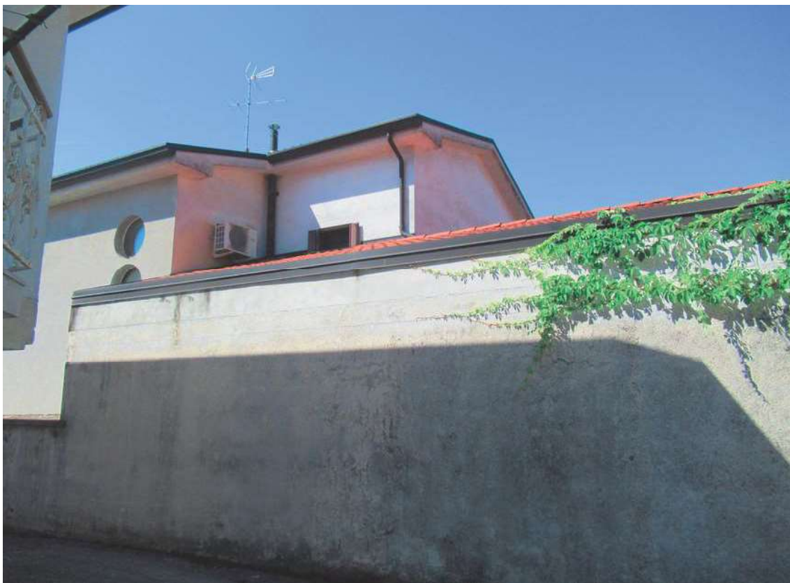
Foto 5: Parete a confine corpo ad un piano
