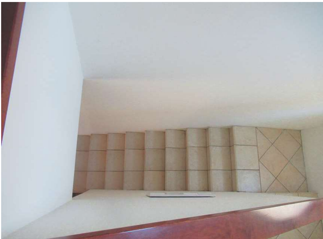
Foto 26: Vano scale visto dall'alto
