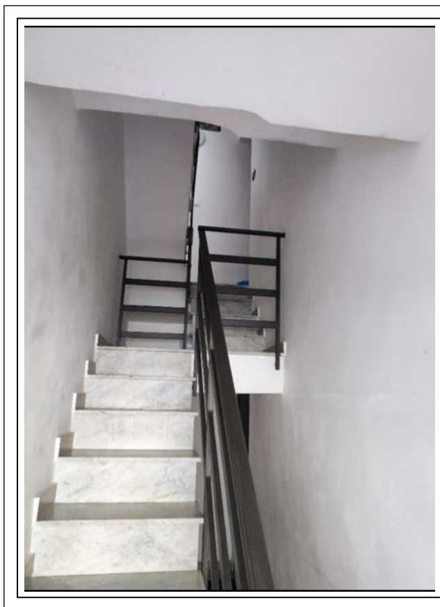
Foto N°7 - Part. scala di accesso con gradini e battiscopa rivestiti in marmo Carrara dotata di corrimano in alluminio anodizzato
