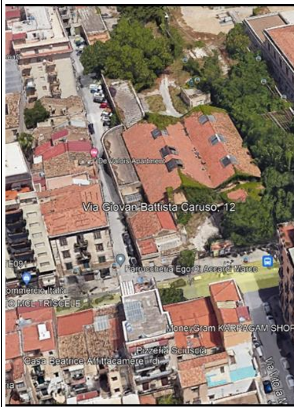
Foto N°1 - Foto aerea tratta da Google Earth con individuazione dell'organismo edilizio
