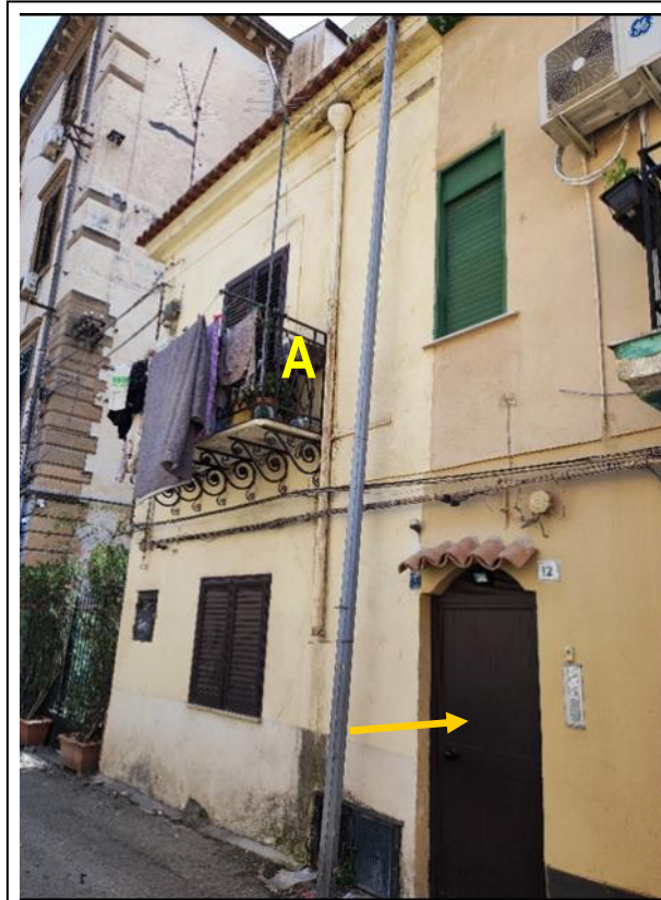
Foto N°4 - L'accesso da Via G.B.Caruso , civ.12; (A) balcone della Camera da Letto 1
