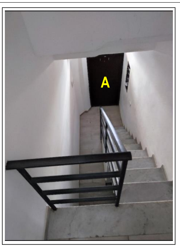
Foto N°6 - Controcampo sulla scala : sullo sfondo ,il portoncino in alluminio anodizzato (A)
