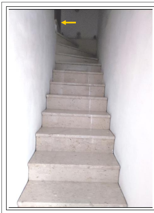
Foto N°9 - Scala di accesso all'unità immobiliare di Piano II
