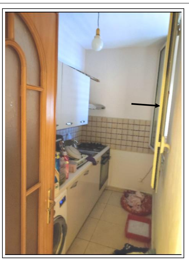
Foto N°14 - Cucina : a dx, serramento in alluminio anodizzato preverniciato, prospiciente la Corte Interna
