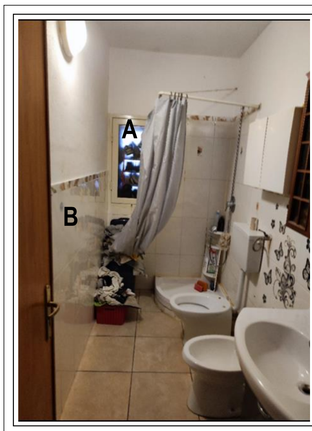
Foto N°13 - W.C.Doccia : (A) nuovo serramento in all.anodizzato; (B) rivestimento con piastrelle ceramiche (cm.30x47) per H= m.1,43
