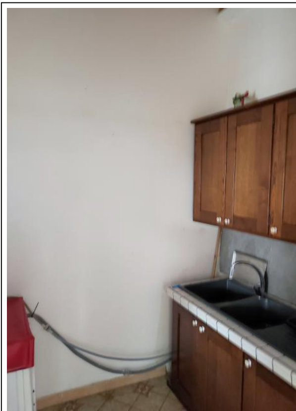
Foto N°12 - Cucina :part. top in muratura, rivestito con piastrelle ceramiche ed elementi da incasso in acciaio inox
