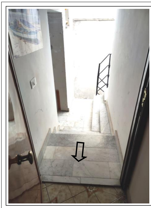
Foto N°7 - Part. accesso all'unità immobiliare di Piano III: gradini rivestiti in marmo Carrara e corrimano in ferro battuto
