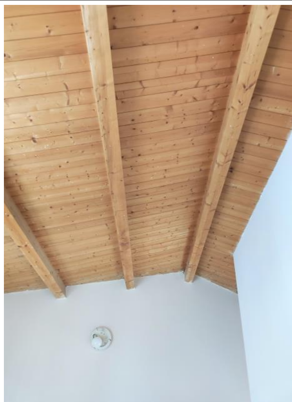
Foto N°9 - Part. intradosso manto di copertura : travetti e perlinato in pitch - pine ;
