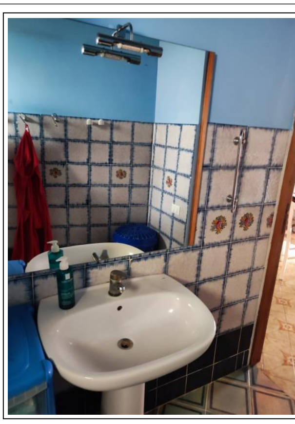
Foto N°20 - W.C. doccia : part. lavabo dotato di mixer in acciaio inox
