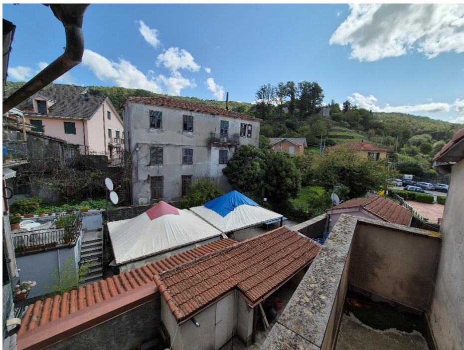
10 poggiolo e vista dal retro
