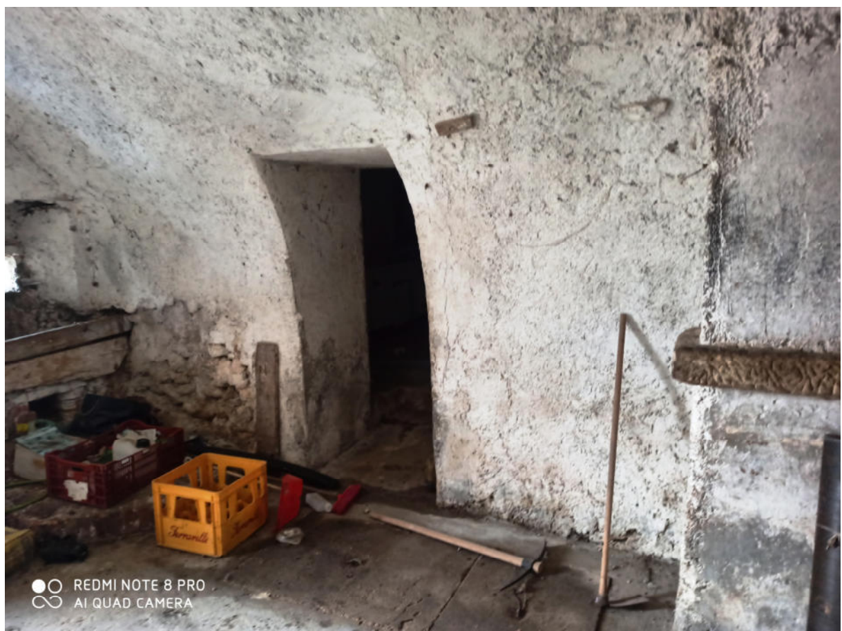
Foto 12 - Vista 2 interno magazzino al piano terra
