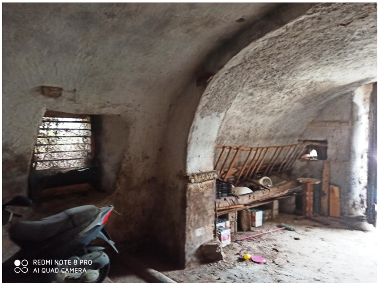
Foto 11 - Vista 1 interno magazzino al piano terra
