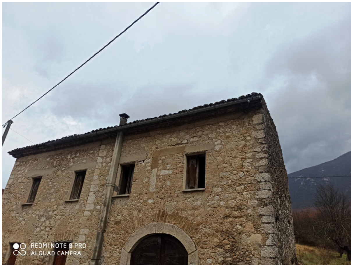
Foto 3 - Facciata principale su via Nazionale
