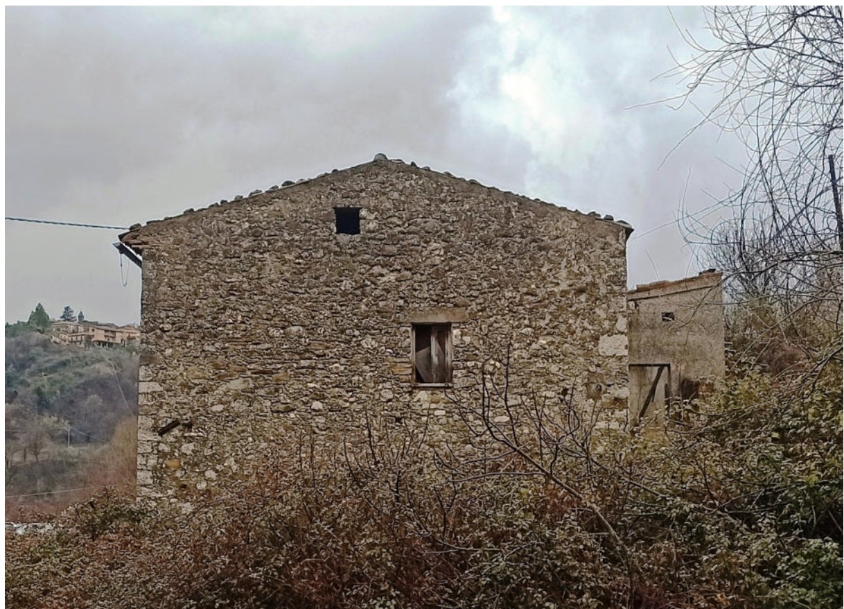
Foto 6 - Vista del fabbricato dal fosso
