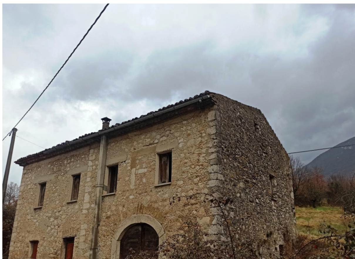
Foto 4 - Facciata principale e facciata lato fosso da via Nazionale
