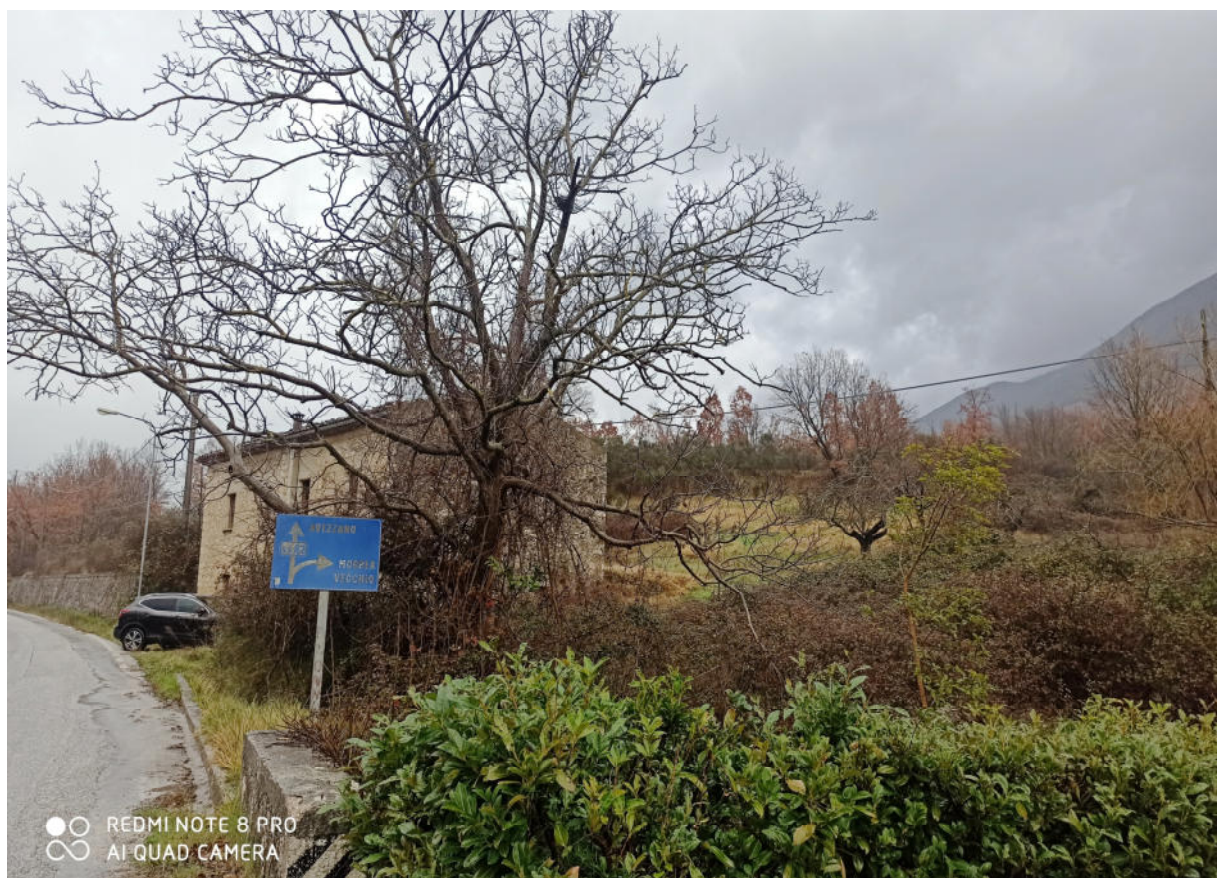
Foto 14 - Vista del fabbricato e della corte circostante
