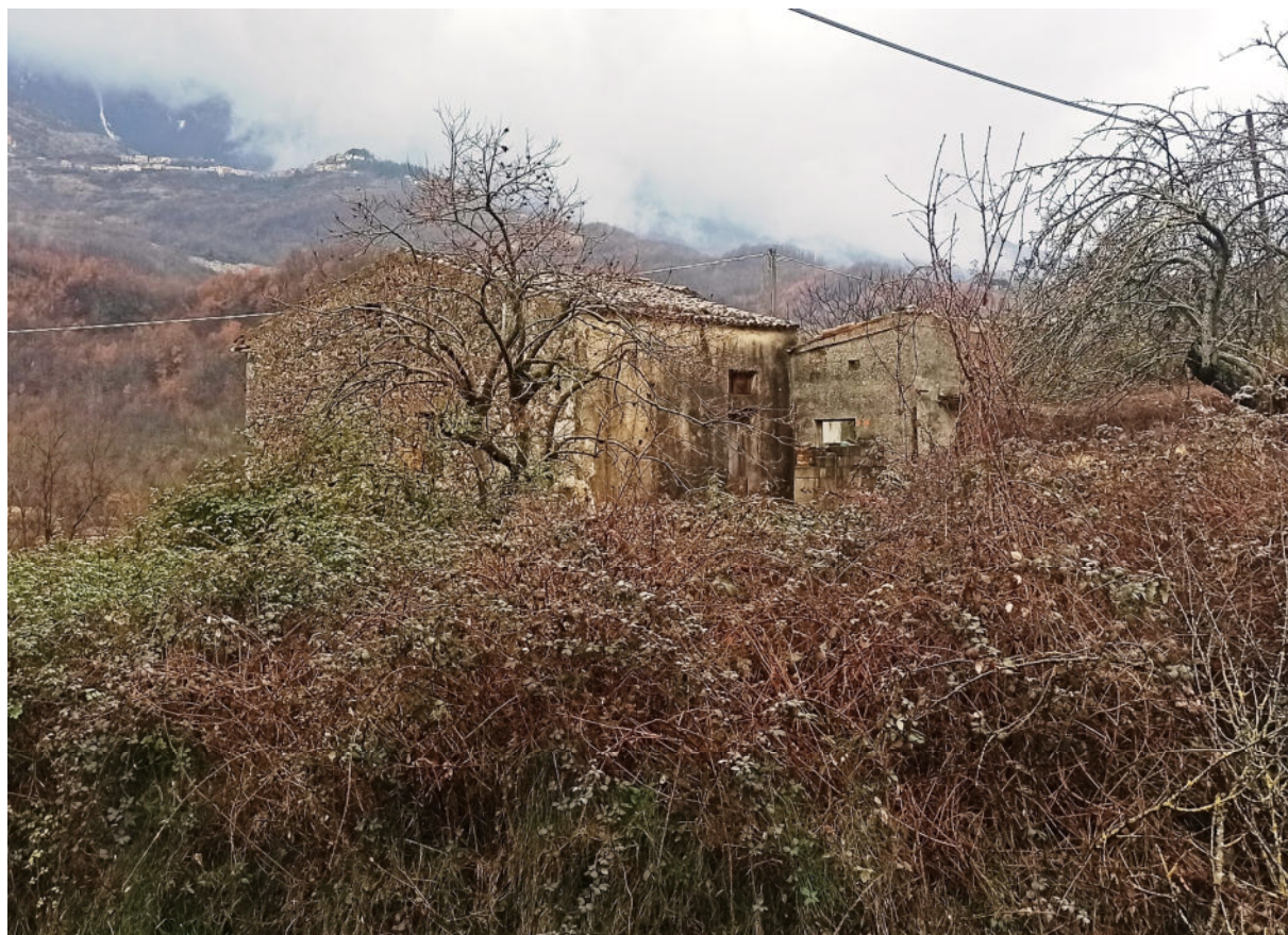
Foto 7 - Vista posteriore del fabbricato
