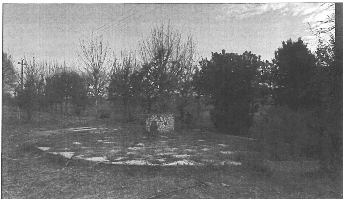
Vista della platea (sopralluogo 20.01.2026)
