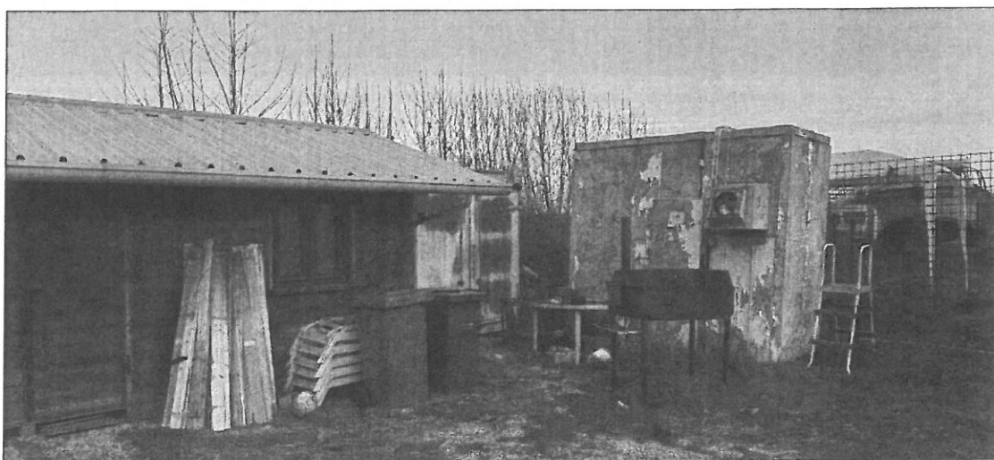
Vista della cella frigo
