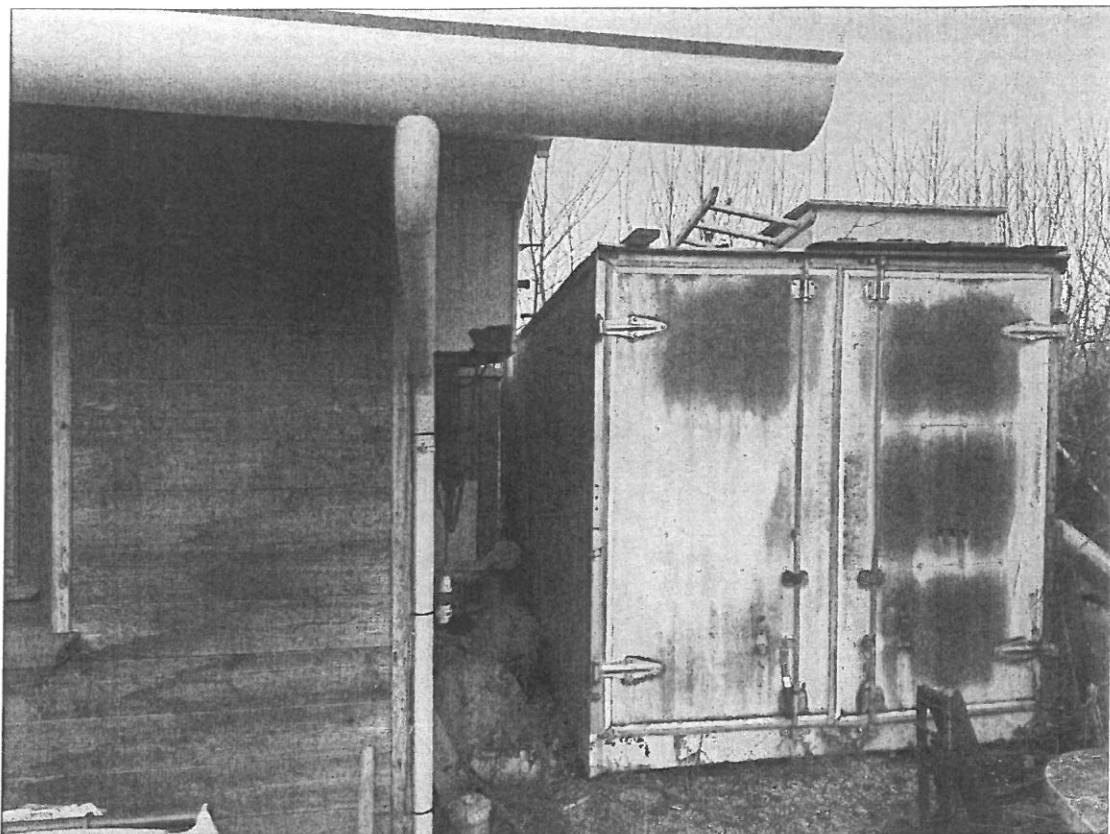
Vista del container
