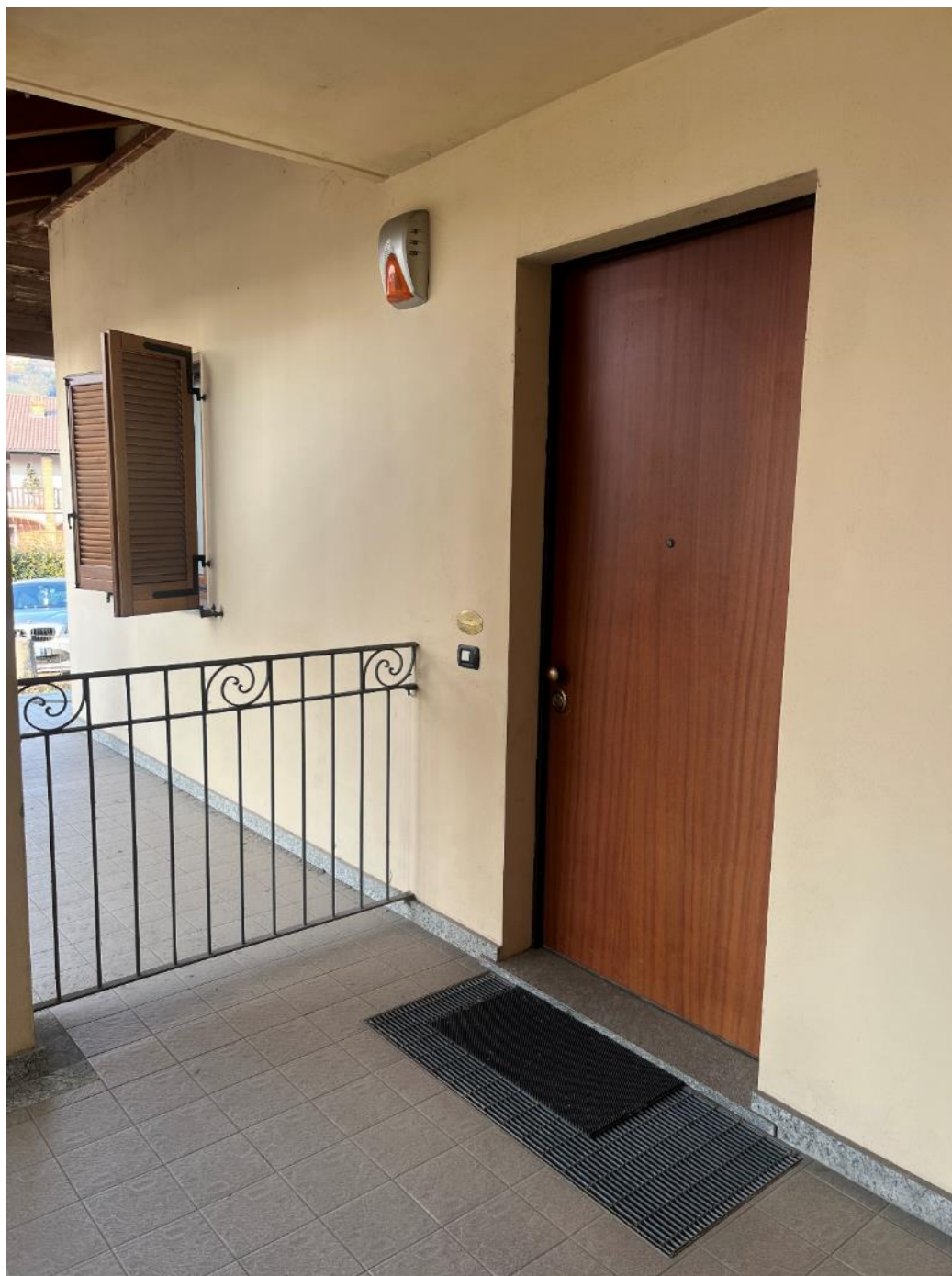
Figura 15: vista dell'ingresso del bene 1
