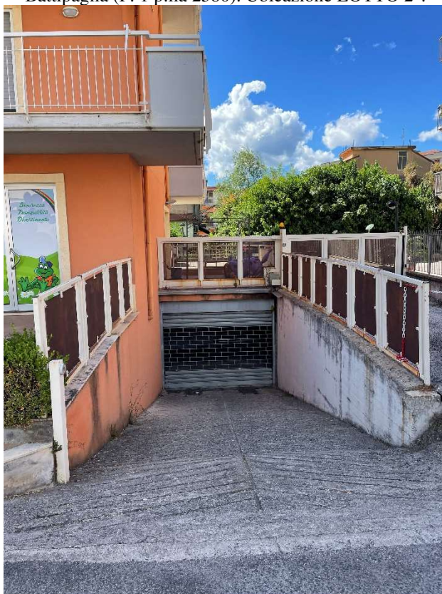
Foto n. 11: Fabbricato “Condominio Girasole” situato alla via Belvedere n. 272 del Comune di Battipaglia (F. 25 p.lla 2580). Rampa NORD accesso locali box piano primo sottostrada con serranda motorizzata.
