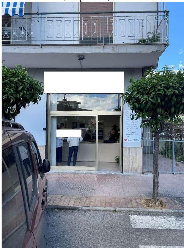
Foto n. 2: LOTTO 1° Negozio Via Giovanni Cuomo n. 115 – Bellizzi (F. 1 p.lla 525 sub. 40). Unico accesso fronte strada.
