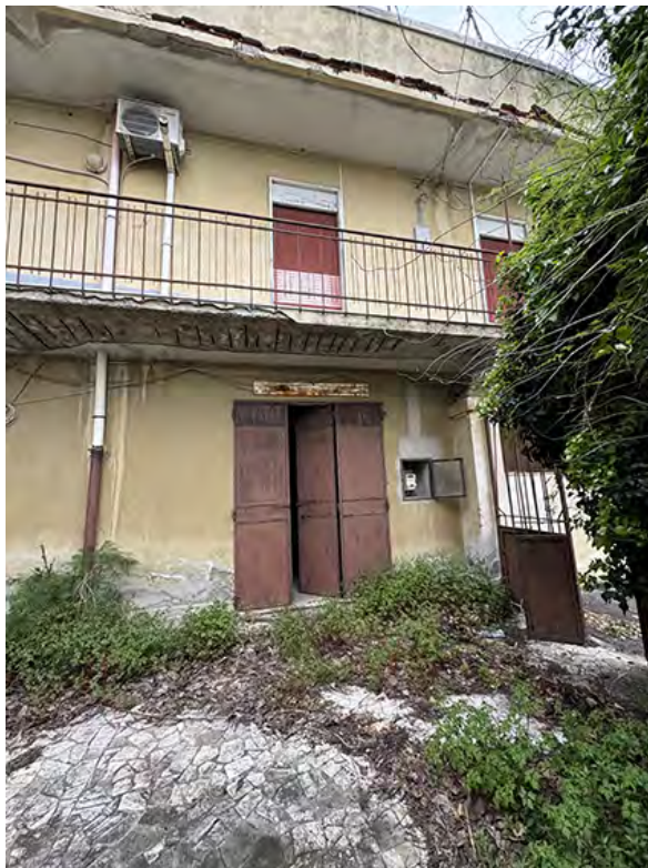
FOTO 2 - Ingresso dalla strada
