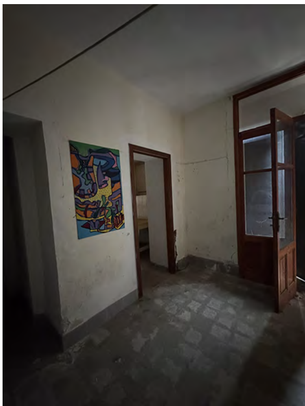
FOTO 13 - Passaggio al vano attiguo
