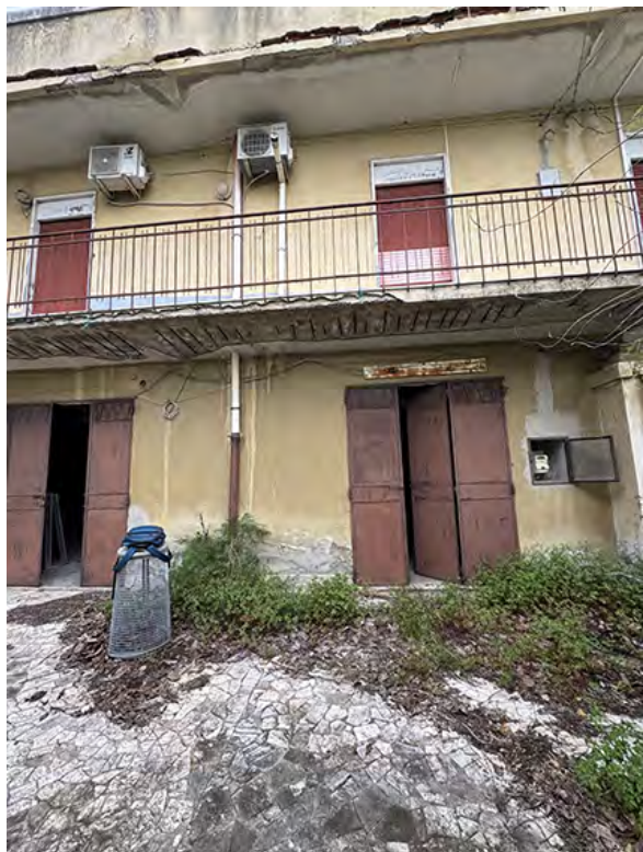
FOTO 3 - Accessi all'immobile piano terra
