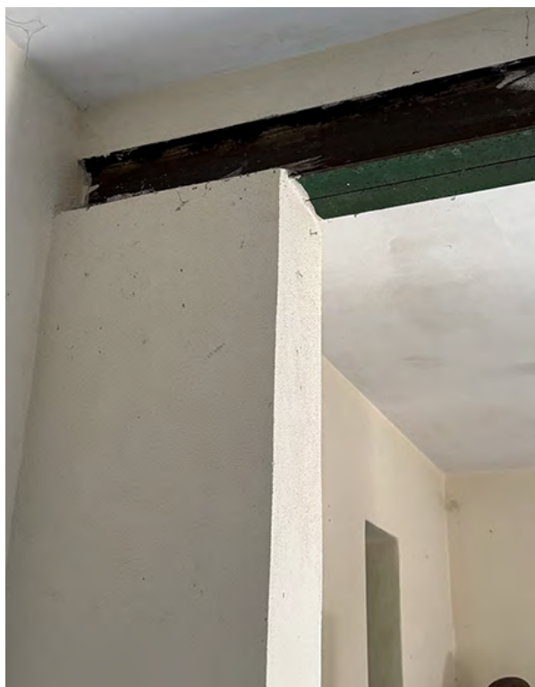
FOTO 9 - Particolare della trave IPE
