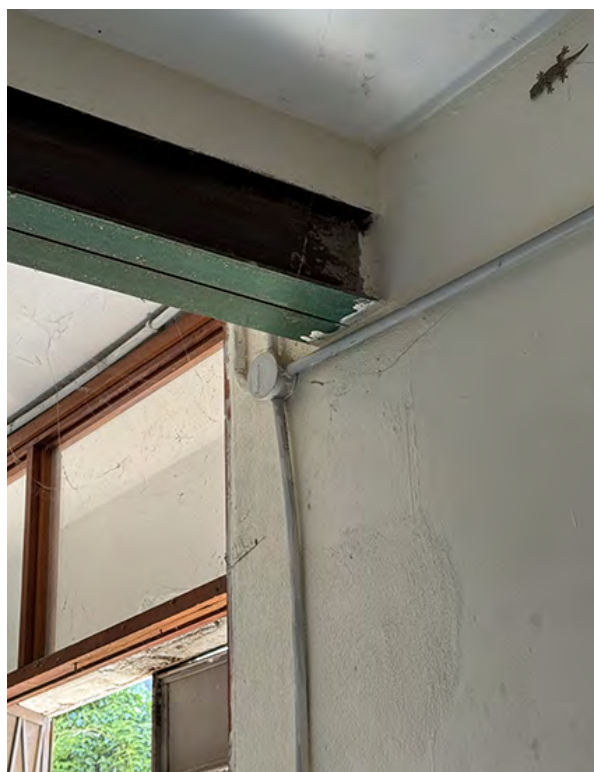
FOTO 10 - Particolare della trave IPE
