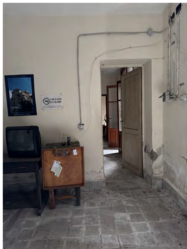
FOTO 11 - Passaggio al vano attiguo
