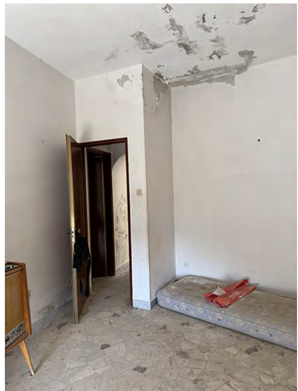
FOTO 12 - Vista dell'ingresso al soggiorno
