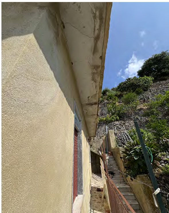
FOTO 25 - Vista rampa cdi accesso al terrazzo
