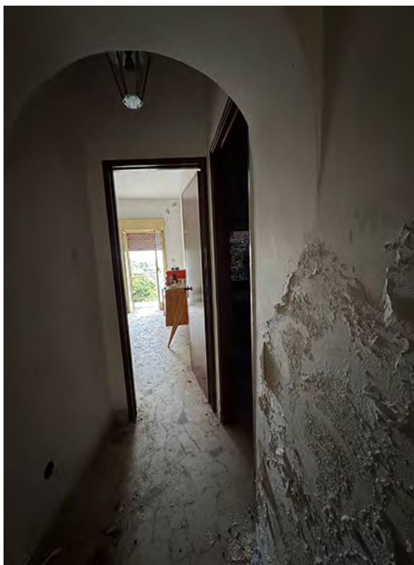
FOTO 17 - Vista del disimpegno
