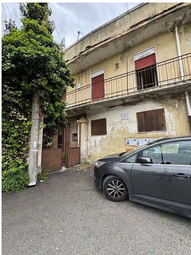
FOTO 1 - Esterno immobile piano primo
