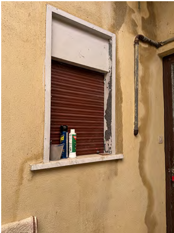
FOTO 21 - Vista della finestra del bagno P.P.
