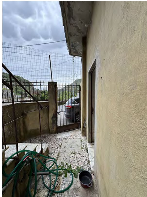
FOTO 2 - Ingresso dalla strada
