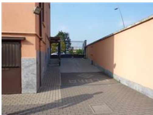
La rampa carraia di accesso
