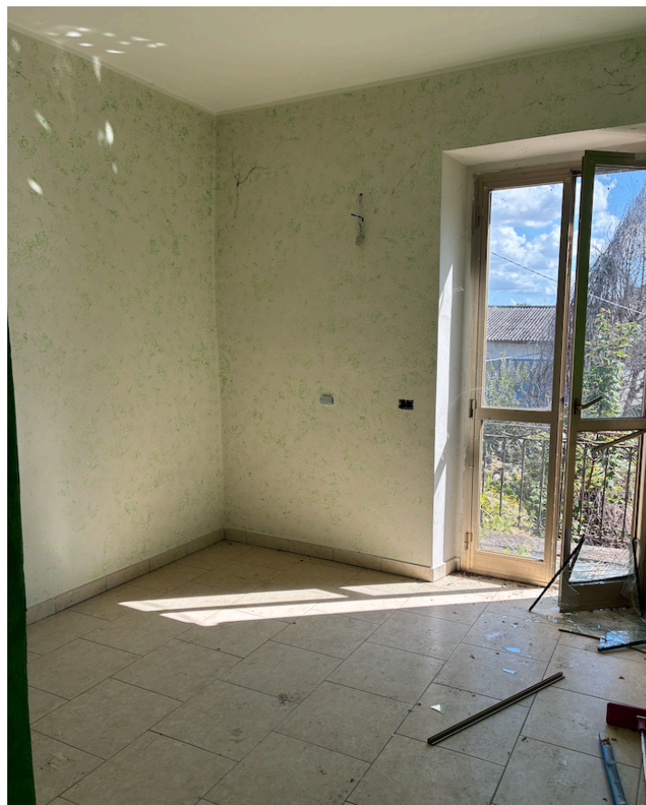
Camera piano primo/secondo, lato sud
