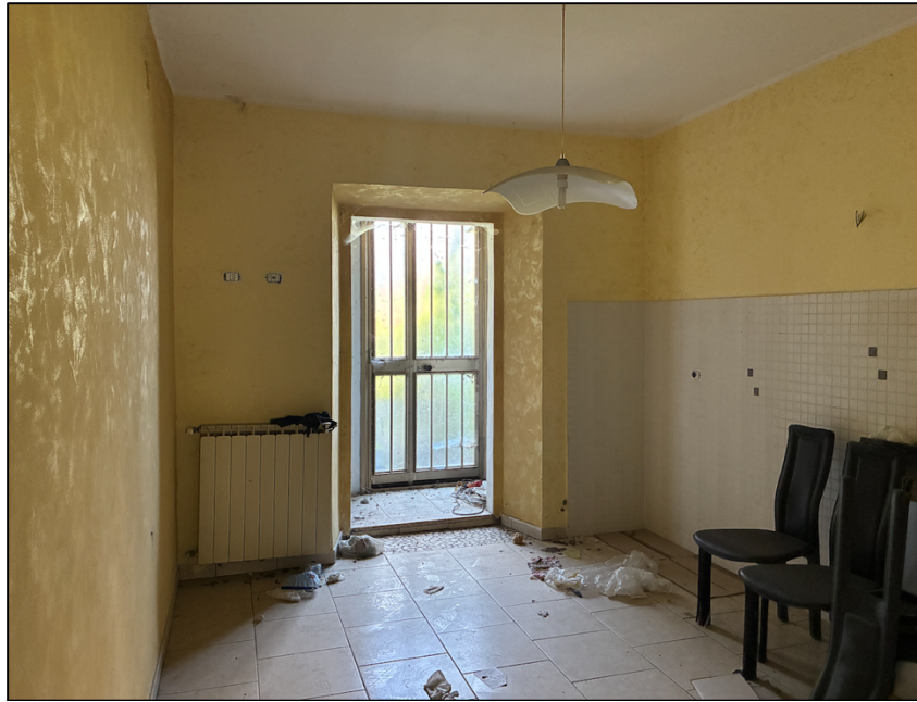
Cucina piano terra/primo, vista verso nord
