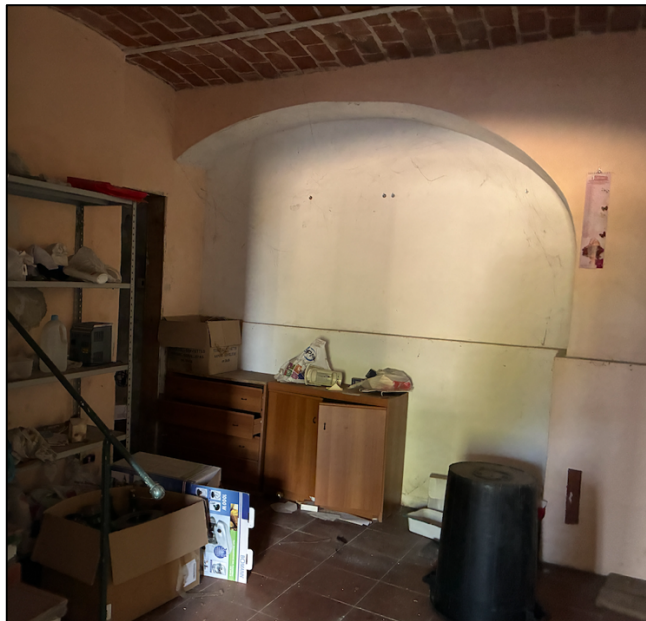
Cantina piano terra/seminterrato lato ovest
