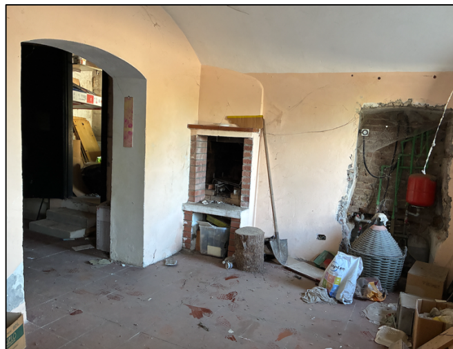
Cantina piano terra/seminterrato lato est (su strada)
