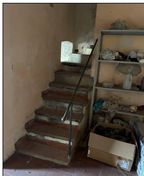
Scala dalla cantina al piano terra/primo
