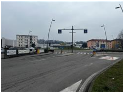
Il fabbricato ed il contesto urbano
