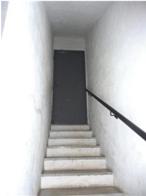
Scala di accesso alle cantine
