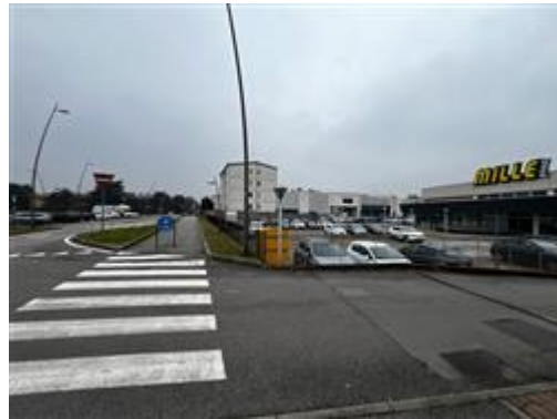
Il fabbricato ed il contesto urbano
