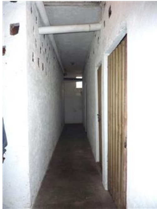
Corridoio di accesso alle cantine
