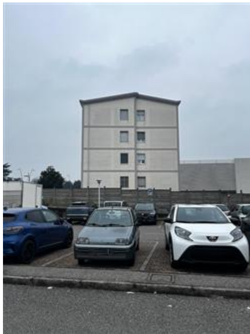
Il fabbricato fronte sud-est
