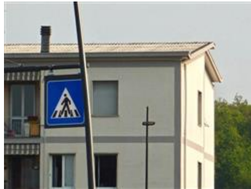
La copertura in lastre di fibrocemento con amianto
