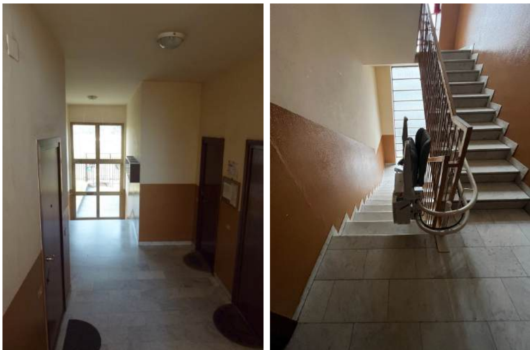
L'INGRESSO VISTO DALL'INTERNO E IL VANO SCALA
