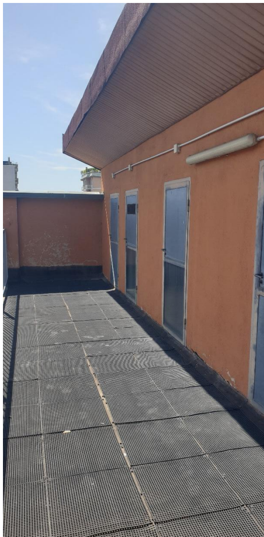
Viste solaio piano 6°
