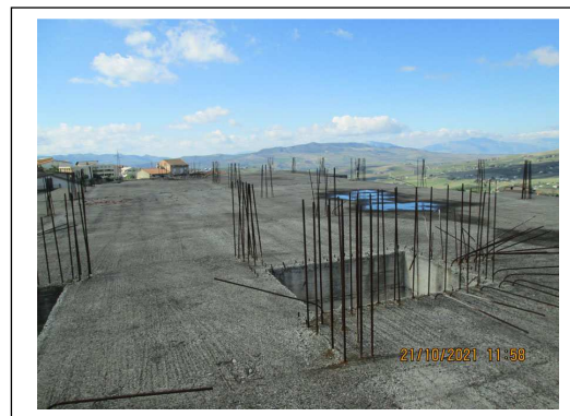
Foto 18. Fabbricato pignorato in corso di costruzione. Solaio del piano secondo (livello abitazioni)
