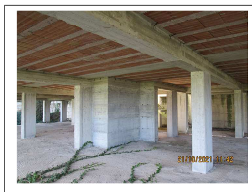
Foto 6. Fabbricato pignorato in corso di costruzione. Piano S1 a livello dei garage
