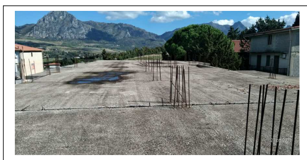
Foto 17. Fabbricato pignorato in corso di costruzione. Solaio del piano secondo (livello abitazioni)
