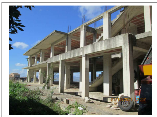
Foto 1. Fabbricato pignorato in corso di costruzione. Fronte sud
