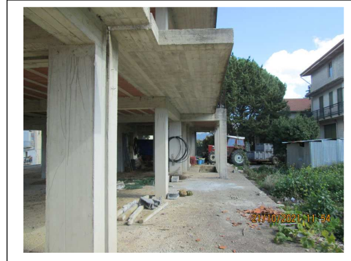
Foto 12. Fabbricato pignorato in corso di costruzione. Piano terra (livello abitazioni)
