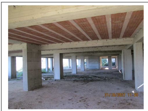
Foto 5. Fabbricato pignorato in corso di costruzione. Piano S1 a livello dei garage
