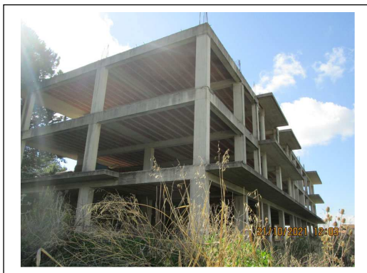
Foto 3. Fabbricato pignorato in corso di costruzione. Fronti est e nord
