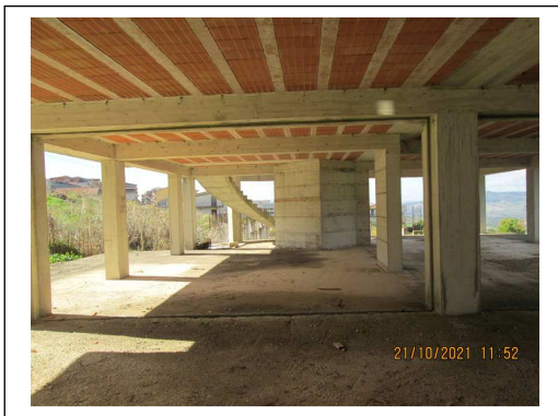
Foto 9. Fabbricato pignorato in corso di costruzione. Piano Terra (livello abitazioni)
