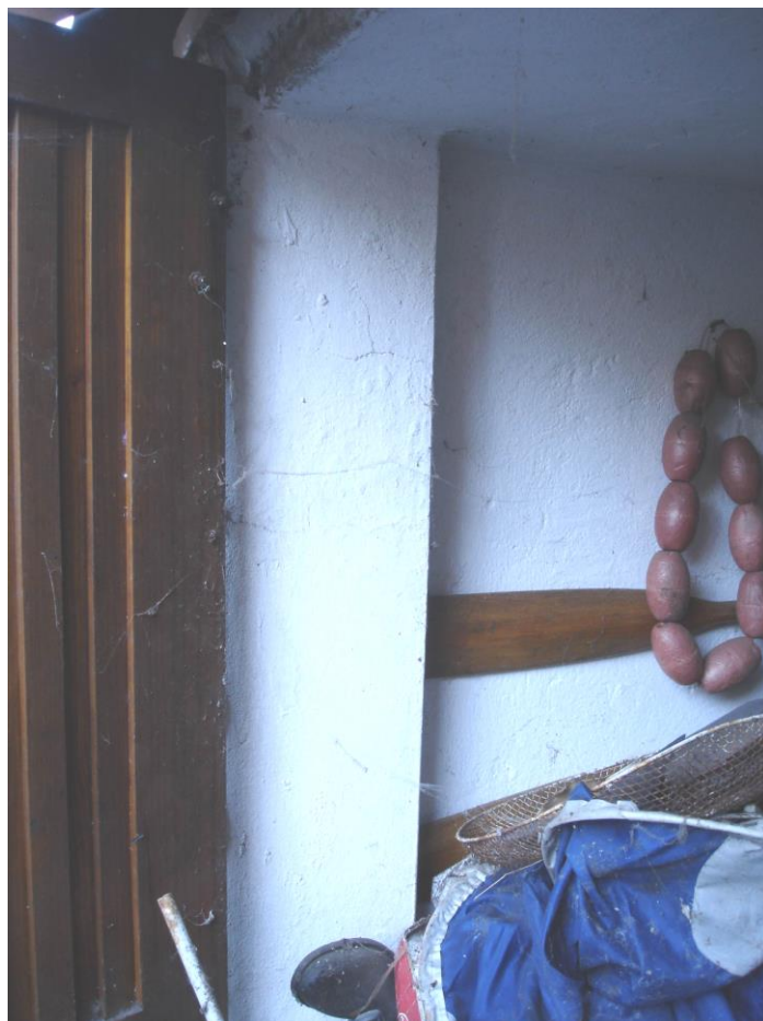
Vista interno porta di ingresso
