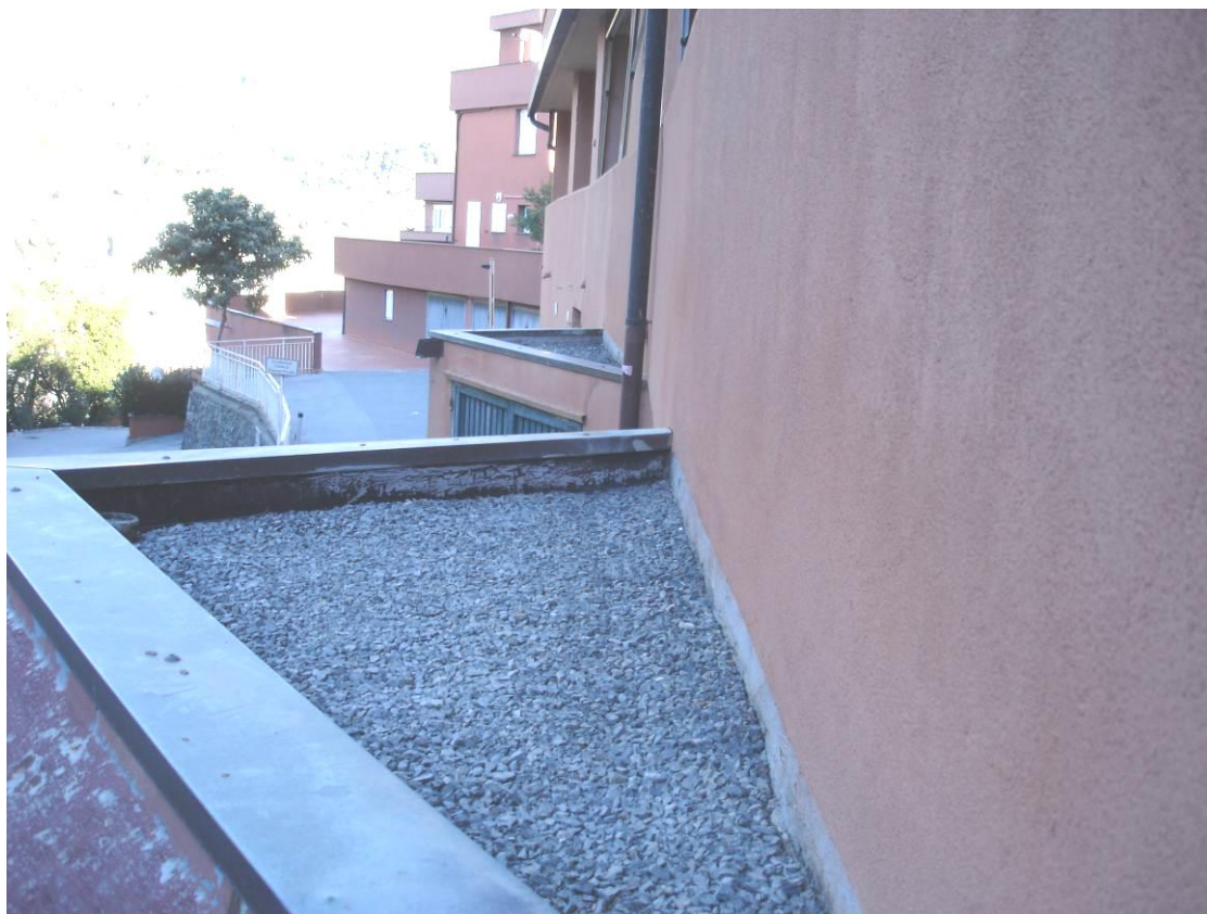
Vista parte della copertura
