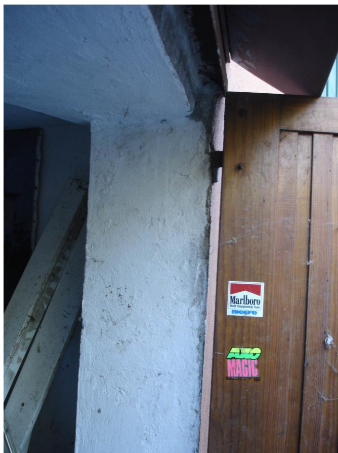
Vista interno porta di ingresso
