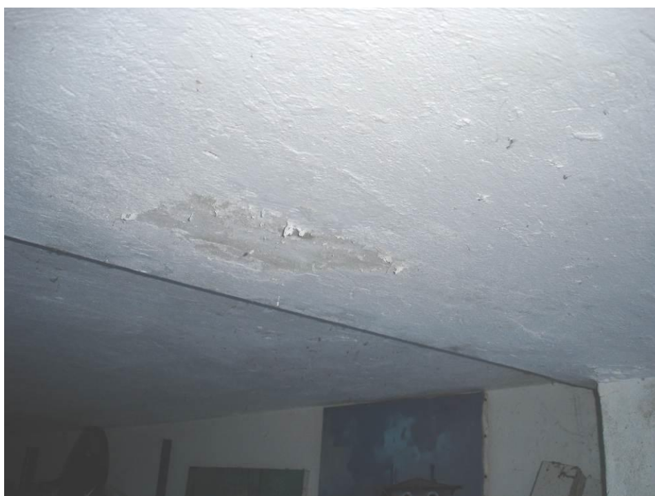
Vista soffitto box
