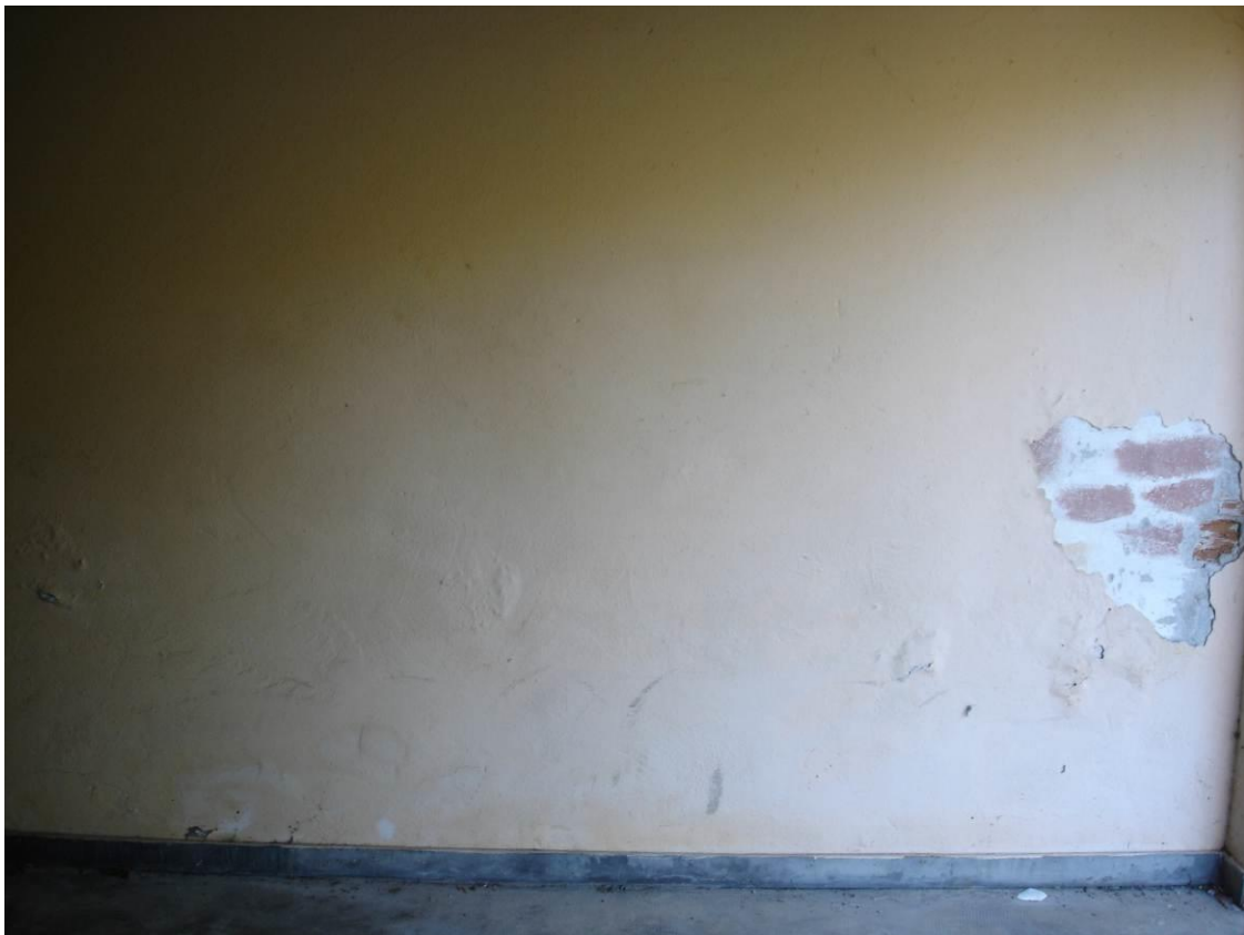
Vista parete esterna (Nord)
