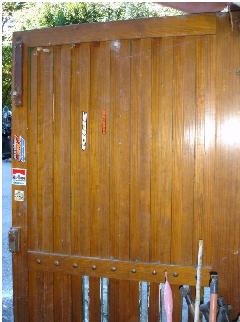
Vista interno porta di ingresso
