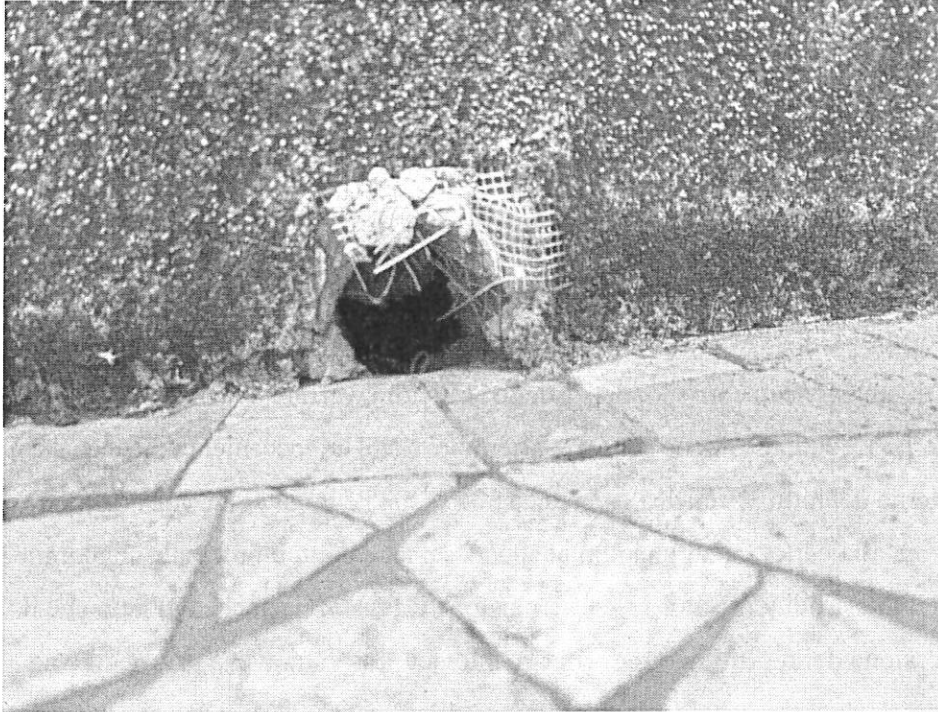
Fig. 18. Originario punto di raccolta delle acque meteoriche del terrazzo d'ingresso condominiale, la cui posizione corrisponde alla tubazione della fig. 17.
