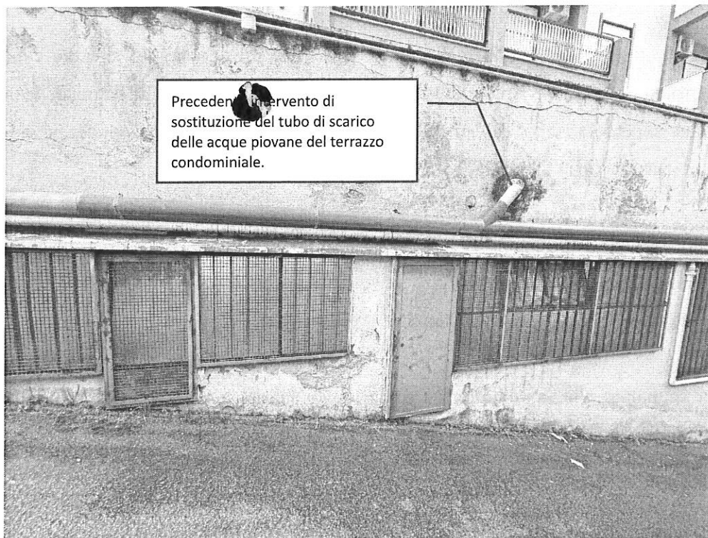
Fig. 17 . Tubazione di scarico delle acque piovane del terrazzo d'ingresso condominiale (foto dell'11/11/2025).
