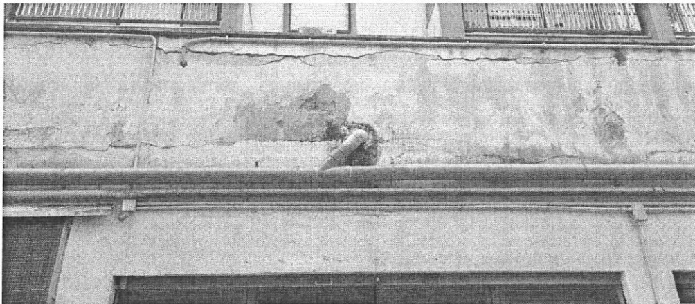
Figura 7 – Lesioni e degradi diffusi localizzati in corrispondenza dell'innesto dei pluviali
