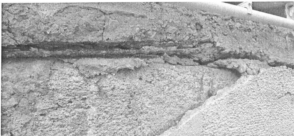
Figura 9 – Ossidazione delle barre di armatura sul muretto d'attico
