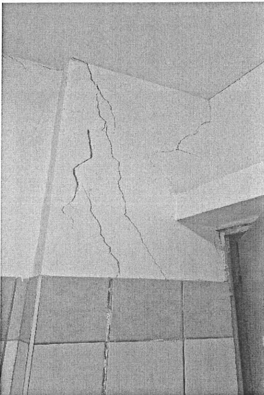
Fig. 10 Pilastro all'interno del wc.
