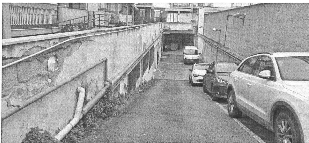
Figura 4 – Rampa di collegamento con il piazzale condominiale
