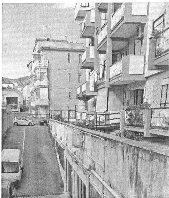
Fig. 4 - Rampa di accesso al lotto 3.
