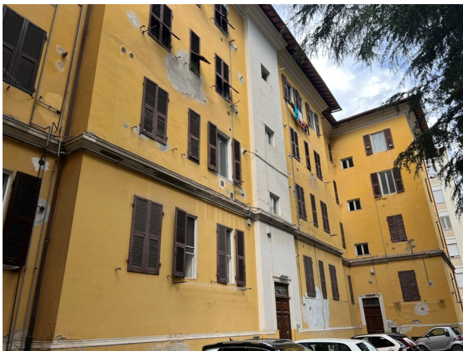
Foto 1 – esterno del fabbricato dalla corte condominiale al piano terra
