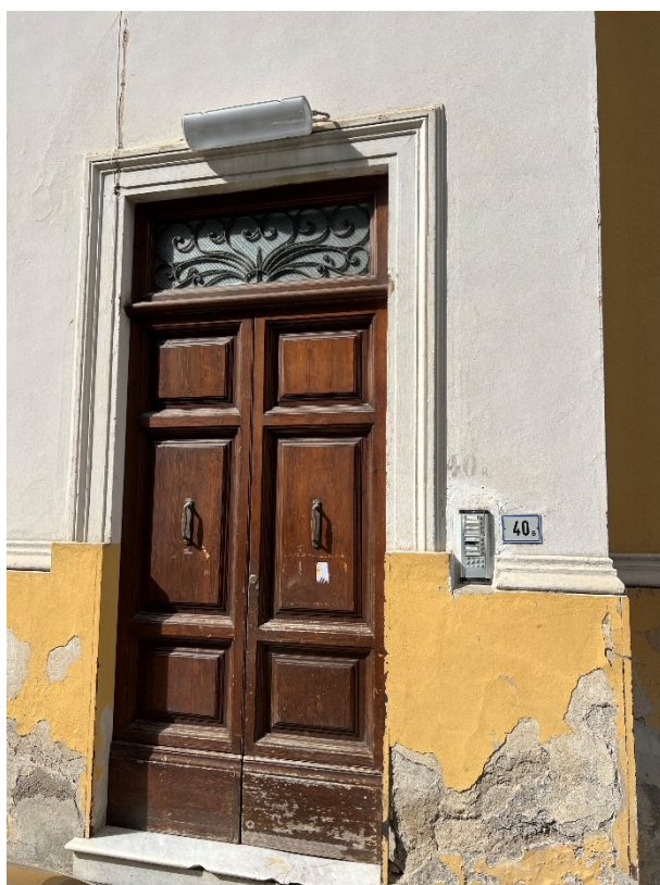
Foto 2 – particolare del portone di accesso al vano scala condominiale, SCALA B
