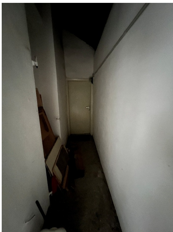
Foto 18 – vista 16 del corridoio comuni tra le soffitte al P.4.
