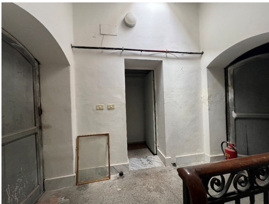
Foto 17 – vista 15 dell'accesso alla soffitta sulle scale comuni al P.4.
