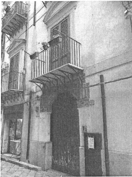
Ingresso su Via delle Pergole 60
