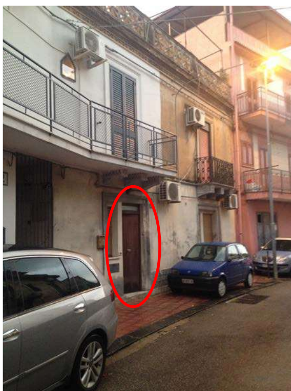
2. Via Comunale Vill. Santo (ingresso unità immobiliare)
