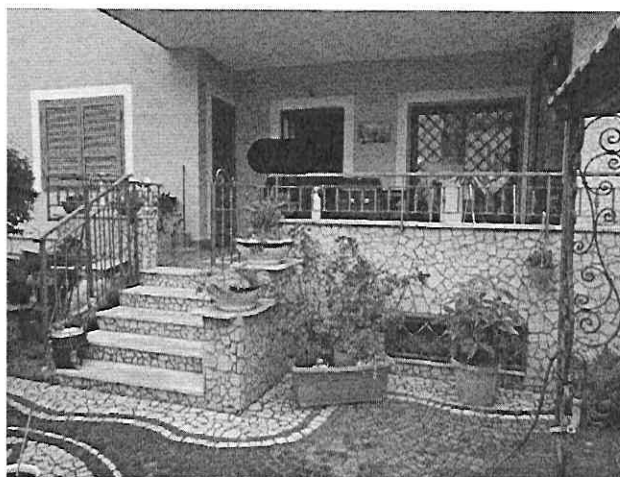
Portoncino d'ingresso al villino SUB 3
