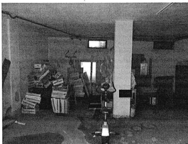
Particolare del locale box auto al PT – SUB 6
