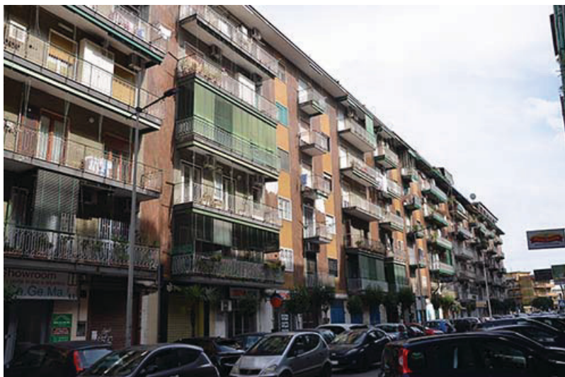
imm.2.03: viste del fabbricato dalla strada
