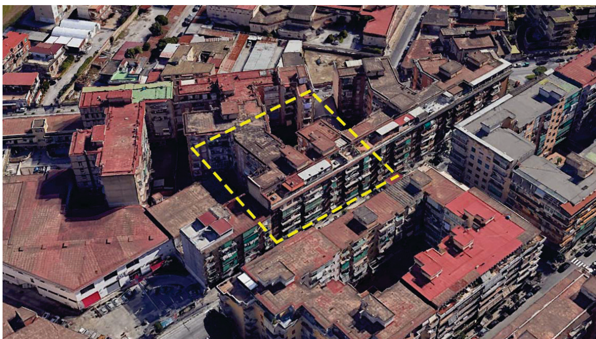
imm.2.02: vista aerea del fabbricato (estratto da Street View®)
