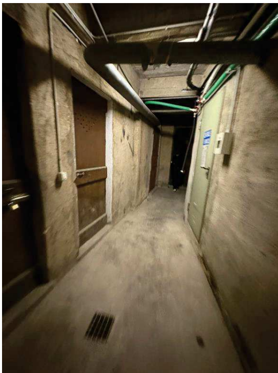
Corridoio condominiale al piano interrato
