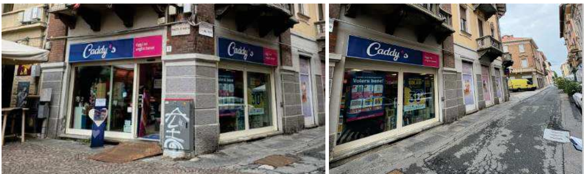
Tre facciate del negozio in via Palazzo di Giustizia n. 1
