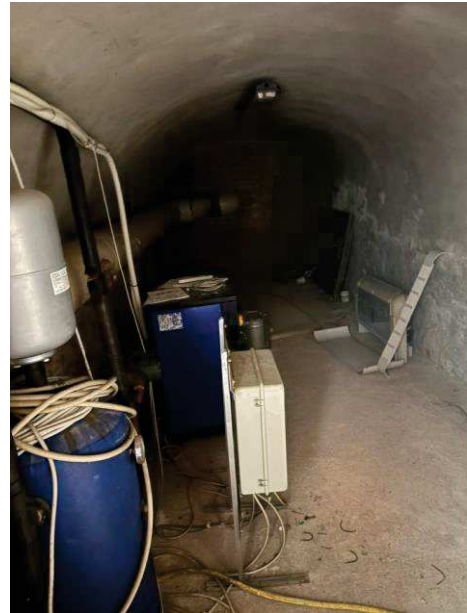
Cantina e centrale termica
