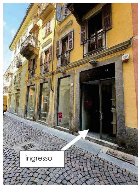
Vista dell'ingresso da via San Filippo
