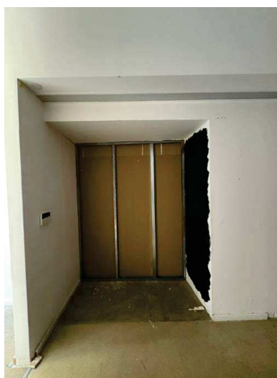
Pareti in cartongesso a separazione dai locali adiacenti in leasing
