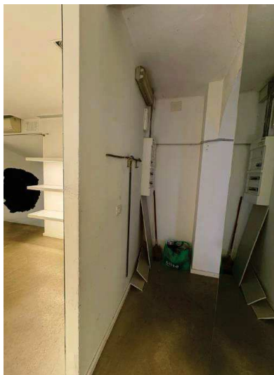
Sub. 24/14 – locale 2 – parete di divisione e ingresso ai locali non finiti
