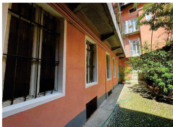
Finestre viste dal cortile di via San Filippo 4
