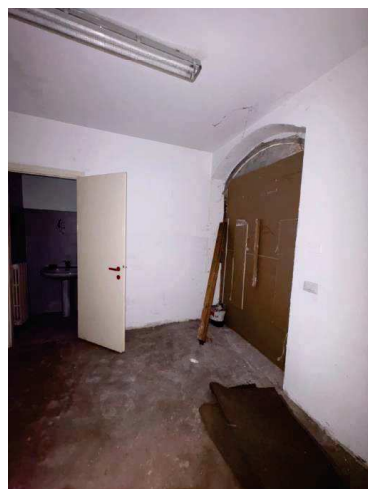
Sub. 23 – locale 5 – e la porta finestra indicata con il n. 7
