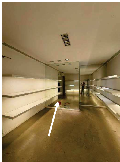
Sub. 24/14 - Parete a specchio – divisione tra la parte finita e quella nella quale non sono stati terminati i lavori – locale 2
