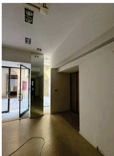
Pareti in cartongesso a separazione dai locali adiacenti in leasing
