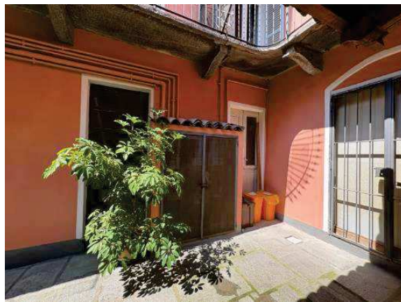
Porta indicata con il numero 5 e finestra n. 6 Sulla destra la porta finestra posta nel locale n. 7 del sub. 23
