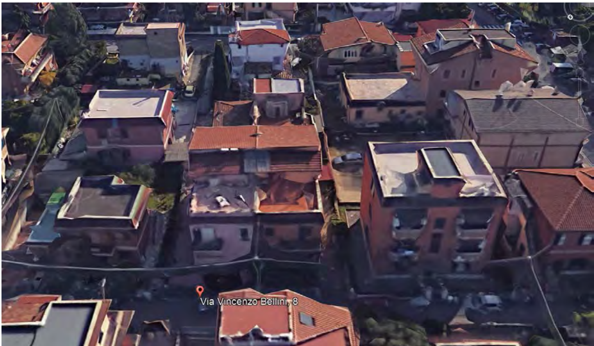
foto 2 - Vista dall'alto 2° piano con terrazzo
