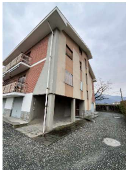
Porticato di accesso al vano scala
