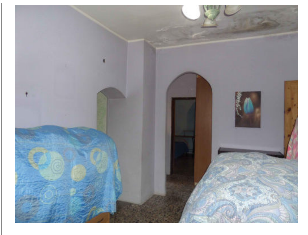
Particolare DISIMP. ADIACENTE BAGNO (N.B.MACCHIE UMIDITA' SOFFITTO)
