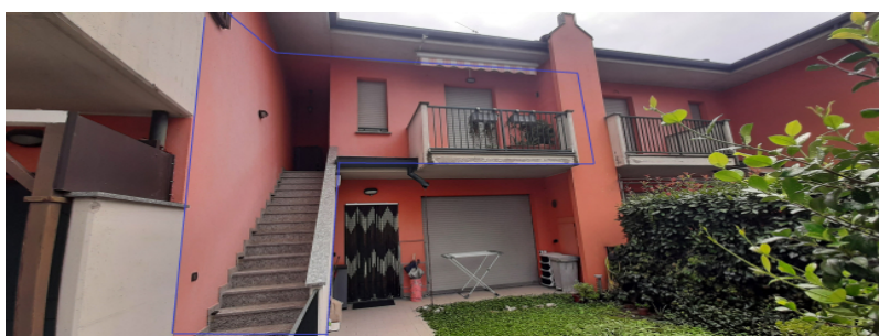
Vista esterna (1° piano)
