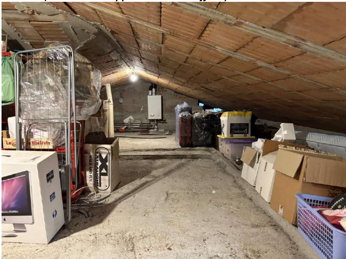
FOTO 14 (vista interna appartamento – soffitta)
