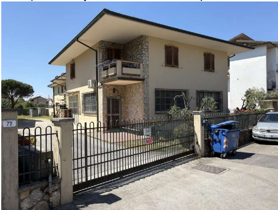
FOTO 1 (vista esterna frontale da via Fratelli Rosselli)
