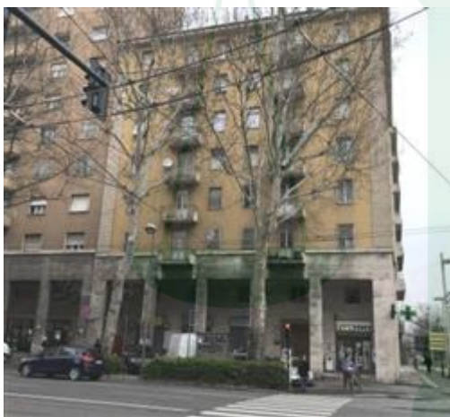
Fronte principale del condominio con il portico su cui si affaccia il negozio.
