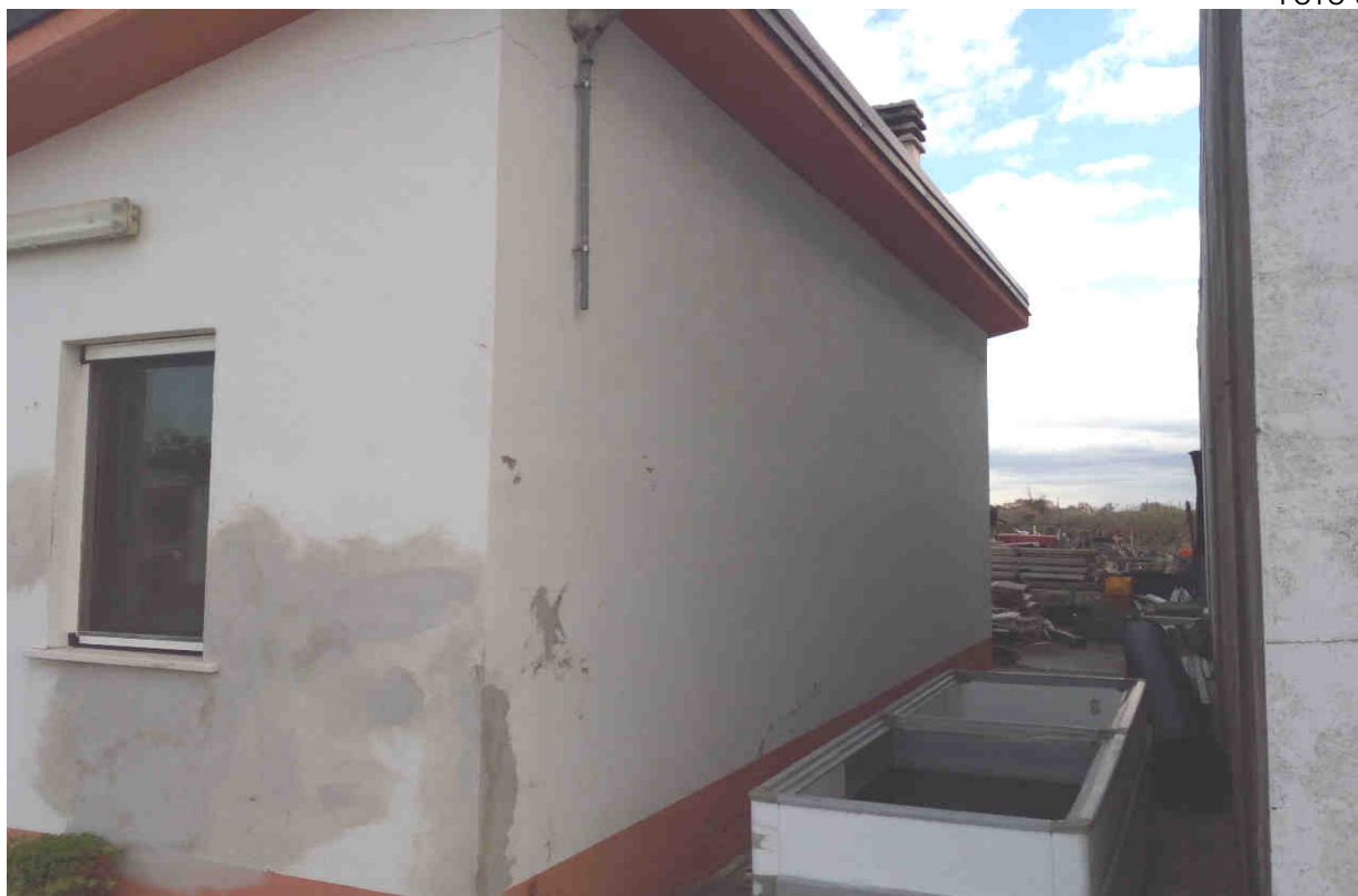
Comune di Policoro Unità immobiliare foglio 3 particella 1450 sub 4 – Prospetto laterale
