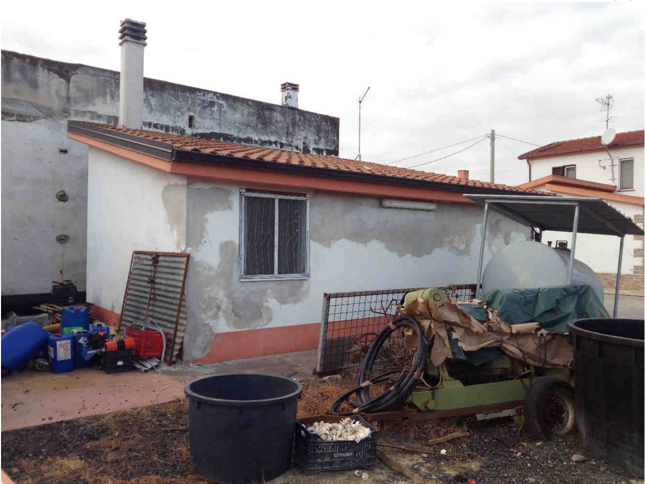
Comune di Policoro Unità immobiliare foglio 3 particella 1450 sub 4 – Prospetto laterale
