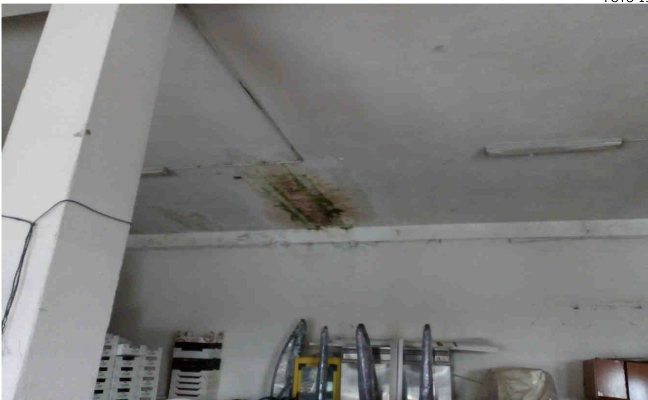
Comune di Policoro Unità immobiliare foglio 3 particella 1450 sub 5 – Interno
