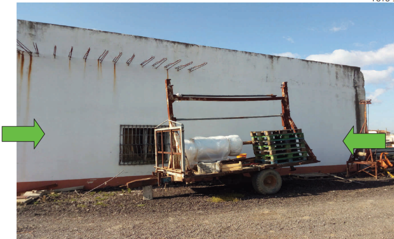
Comune di Policoro Unità immobiliare foglio 3 particella 1450 sub 5 – Capannone Prospetto "B" Concessione n. 79/79 – Finestra
