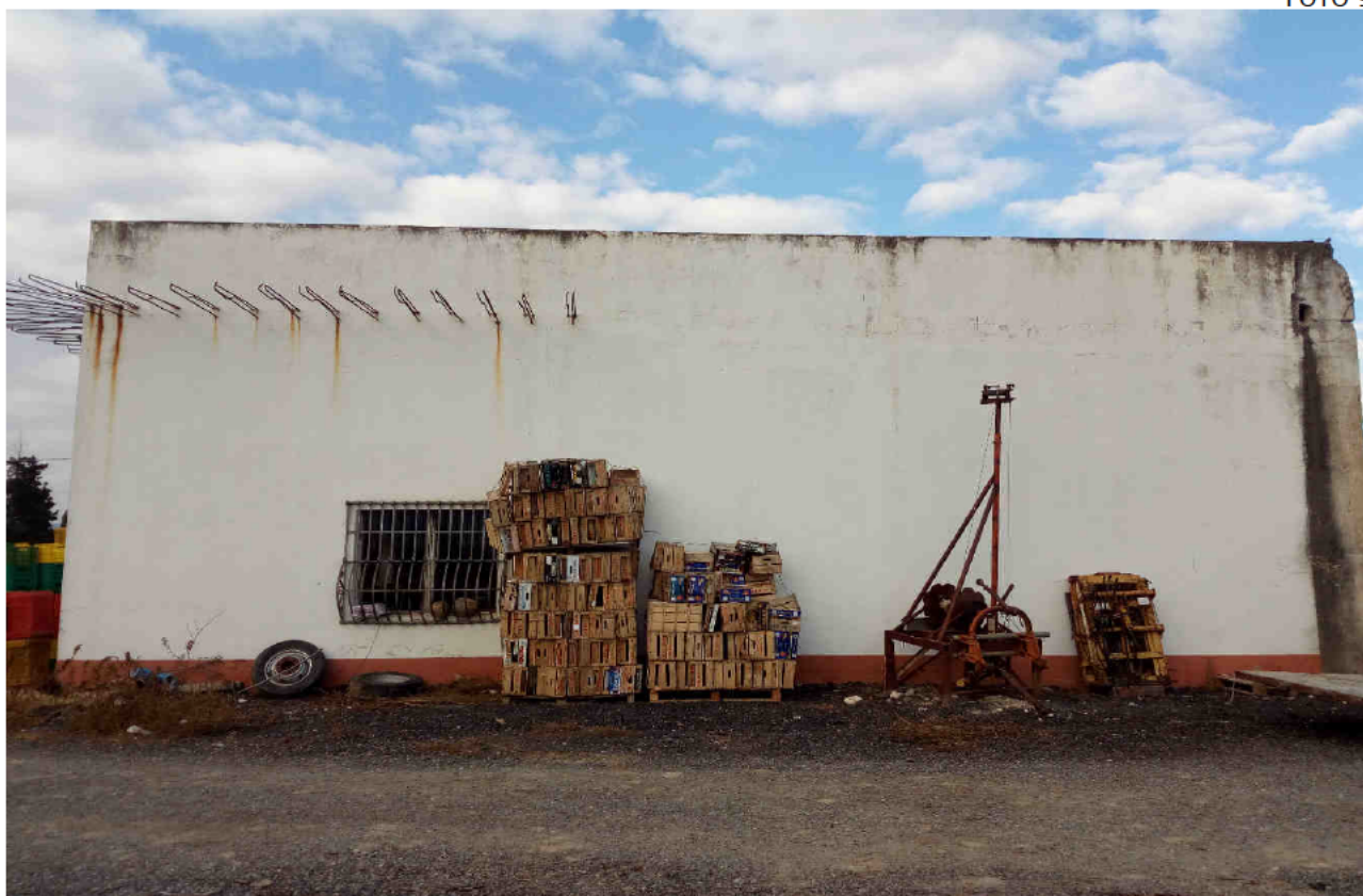
Comune di Policoro Unità immobiliare foglio 3 particella 1450 sub 5 – Prospetto laterale
