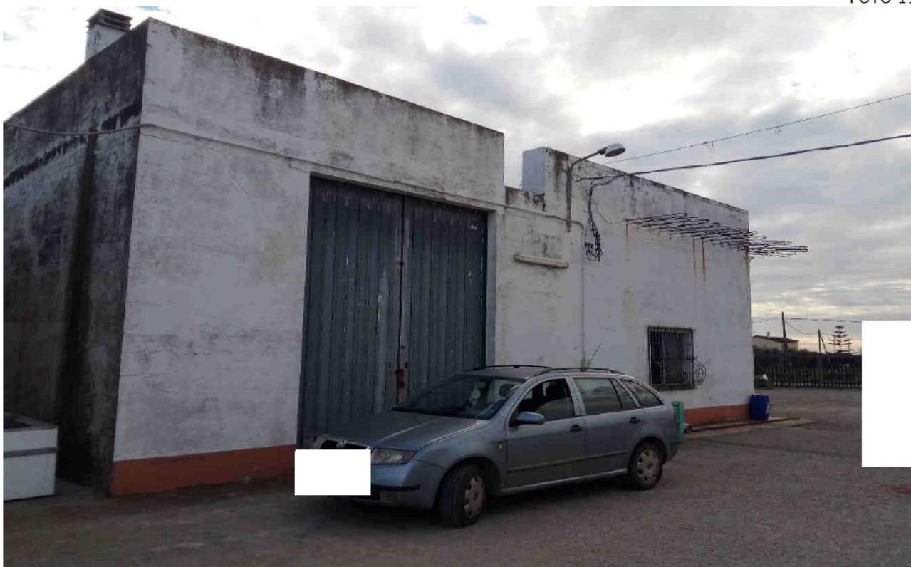
Comune di Policoro Unità immobiliare foglio 3 particella 1450 sub 5 – Prospetto laterale
