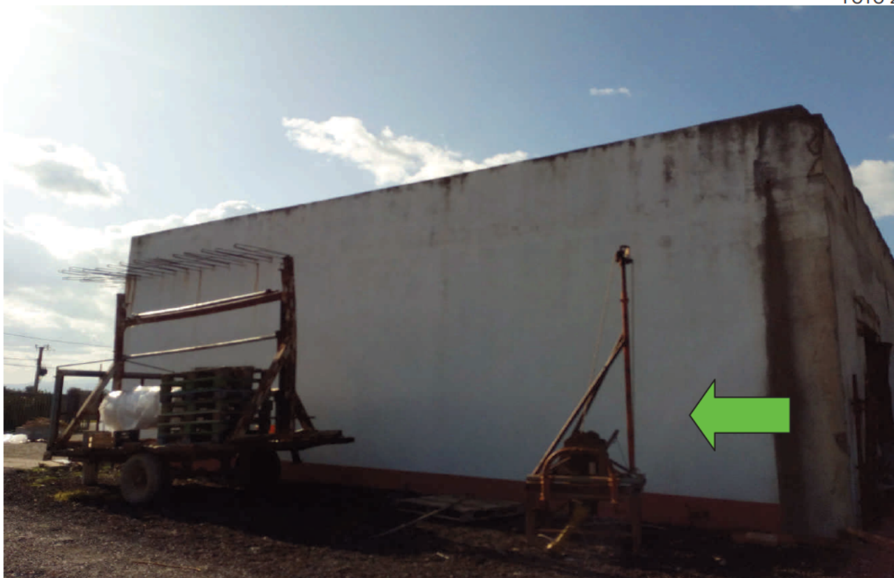
Comune di Policoro Unità immobiliare foglio 3 particella 1450 sub 5 – Capannone Prospetto "B" Concessione n. 79/79 – Finestra
