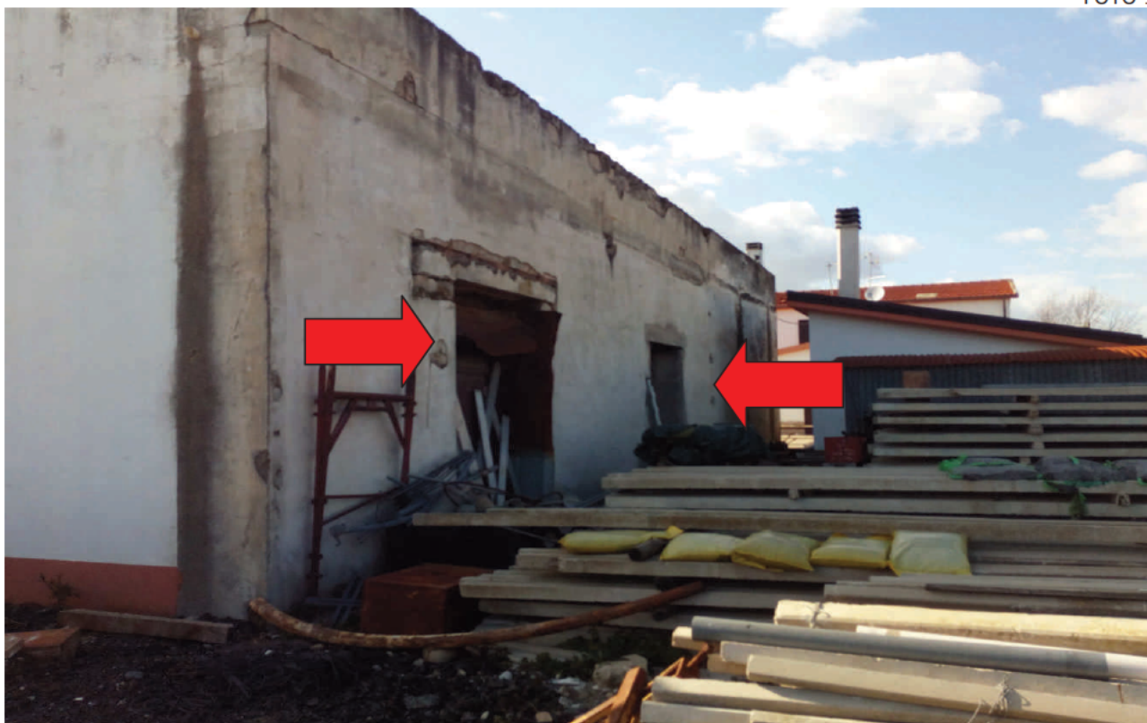
Comune di Policoro Unità immobiliare foglio 3 particella 1450 sub 5 – Capannone Prospetto "A" Concessione n. 79/79 – Porte
