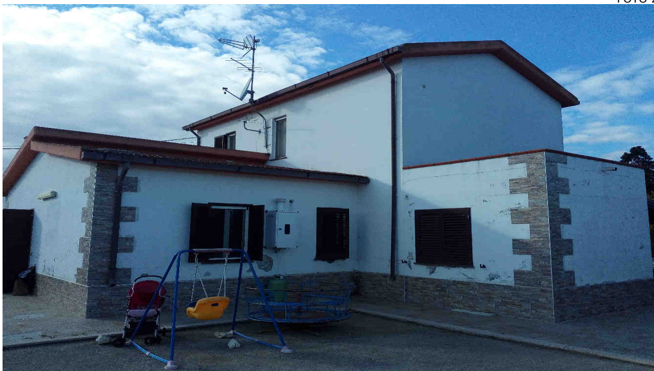
Comune di Policoro Unità immobiliare foglio 3 particella 1450 sub 2 – Prospetto laterale
