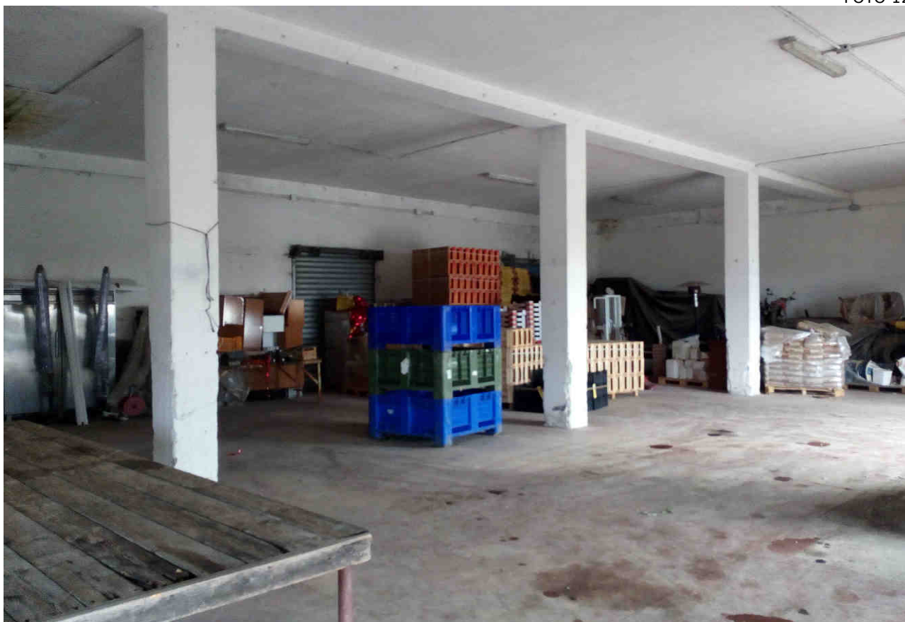
Comune di Policoro Unità immobiliare foglio 3 particella 1450 sub 5 – Interno
