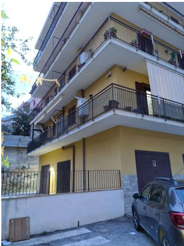
Prospetto lato Sud Edificio
