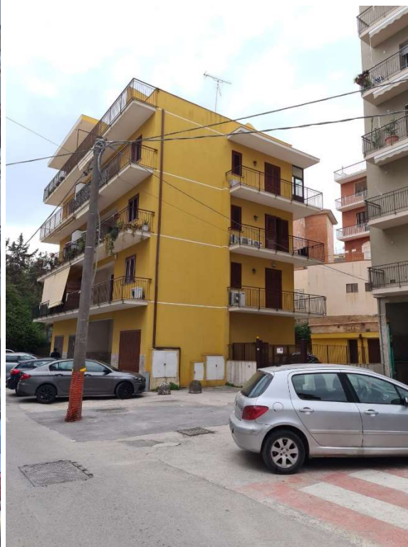
Prospetto lato nord Edificio
