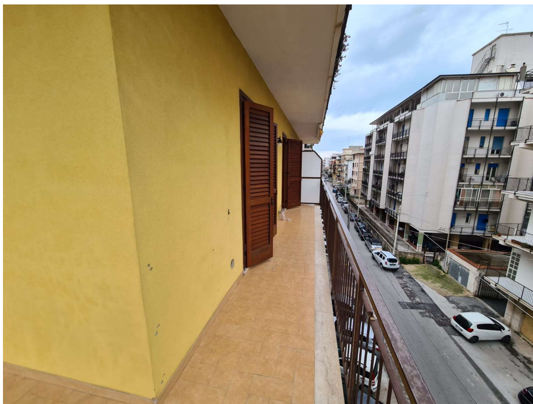
Balcone lato est su via Grotta Santa
