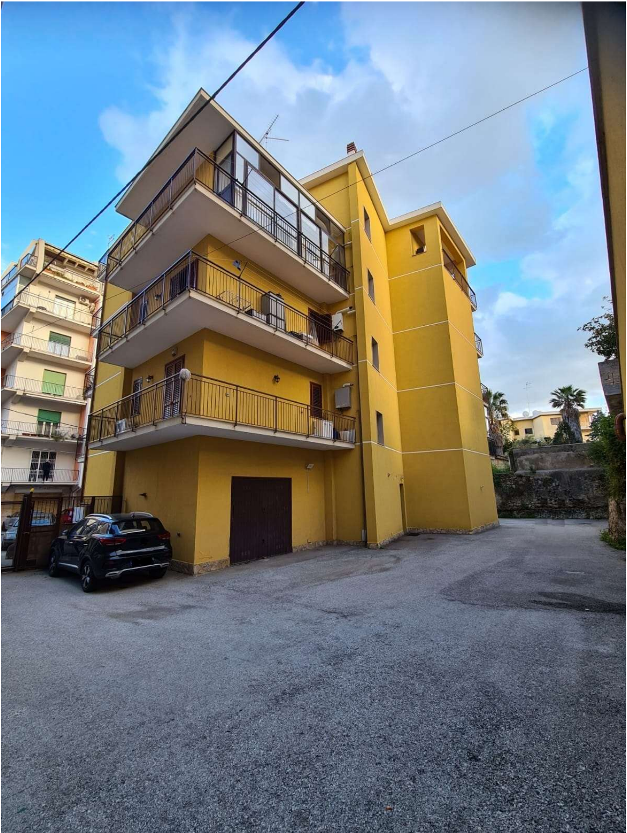
Prospetto Est lato cortile interno Edificio
