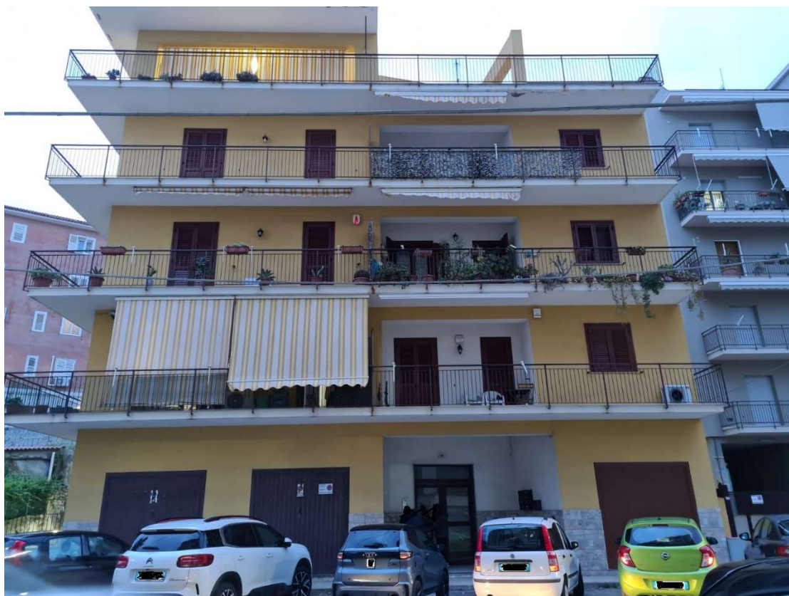
Prospetto principale Edificio
