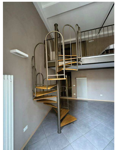
Scala di accesso al soppalco
