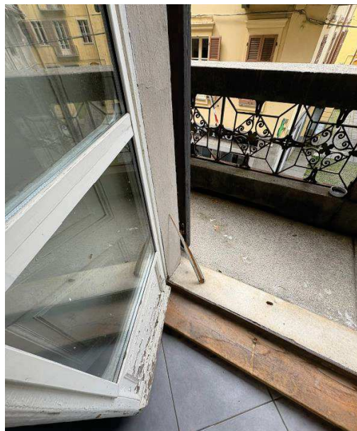
Porte finestre in legno affacciate sul balcone
