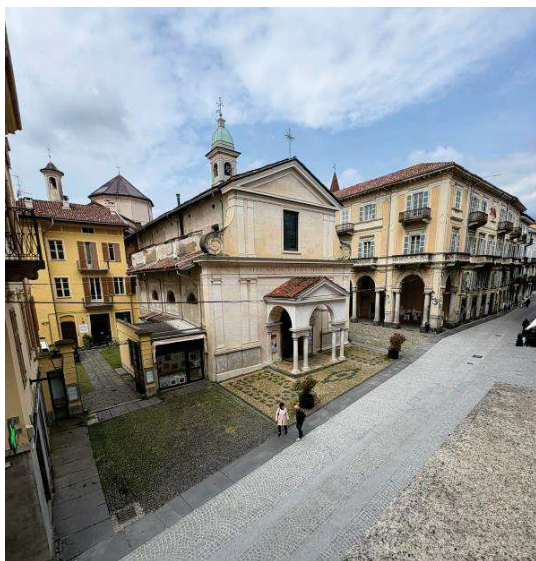
La chiesa vista dal balcone
