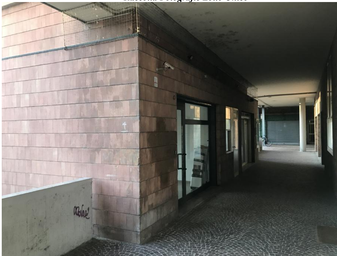
Vista dell'immobile dal porticato di accesso
