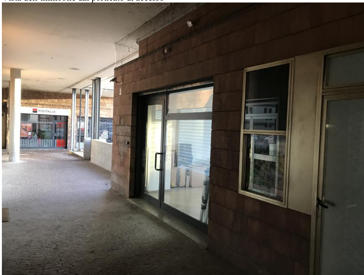
Vista dell'immobile dal porticato di accesso -controcampo
