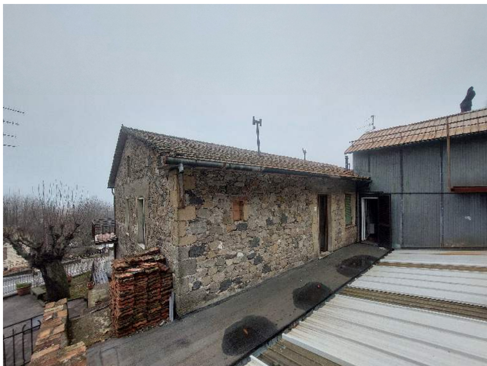
FOTO 3 Veduta dal retro del bene oggetto di valutazione
