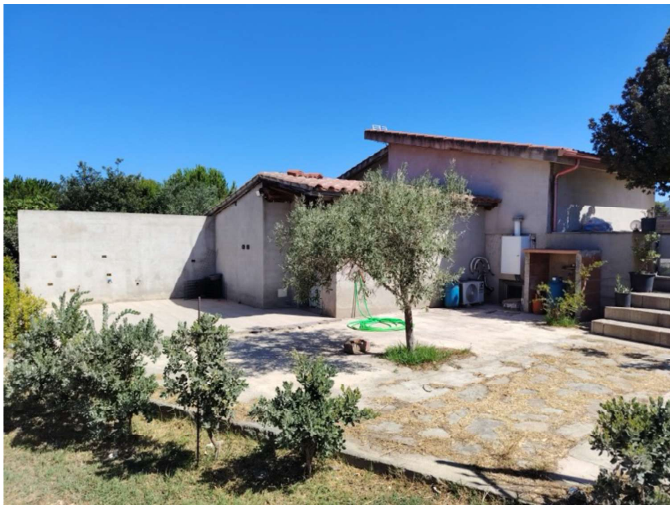
Fig. n. 3 La residenza vista dal varco carrabile di ingresso.
