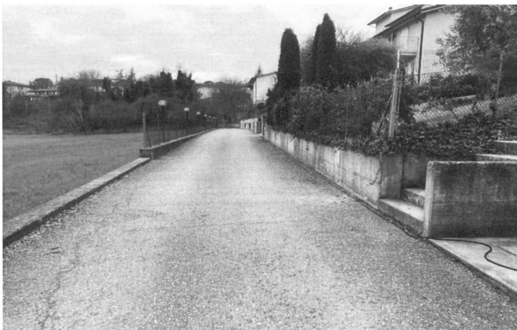
Foto 13 – Area a strada
