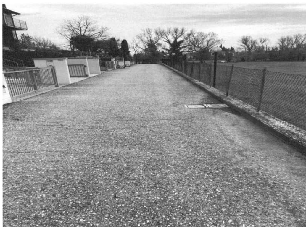
Foto 14 – Area a strada
