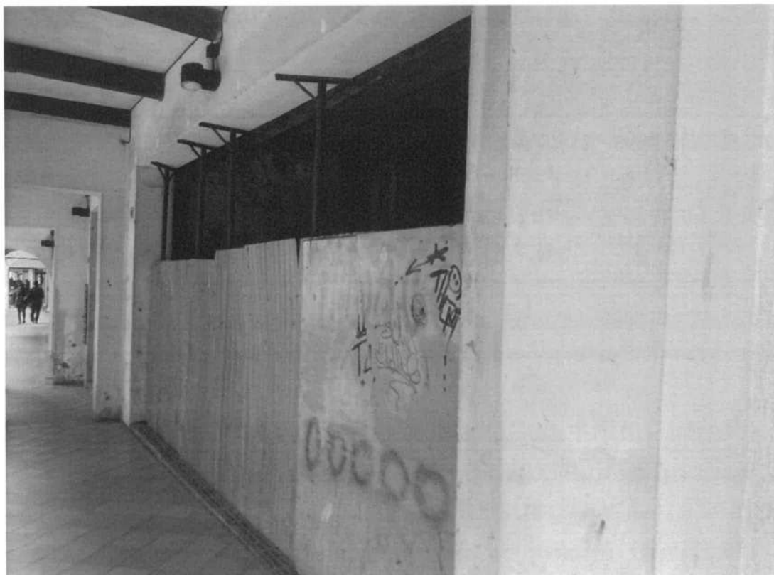
Foto 10 – Sbarramento Cantiere lato Via Cavour
