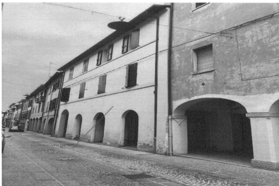
Foto 8 – Edificio sede dell’immobile.
