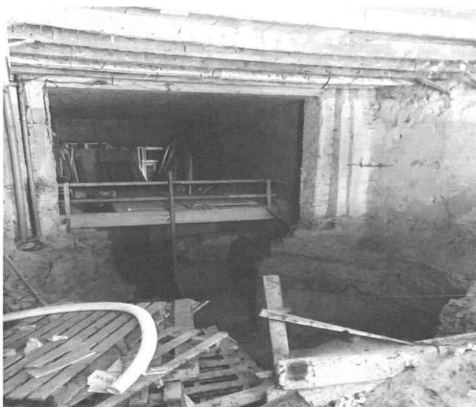
Foto 9 – Stato dei lavori
