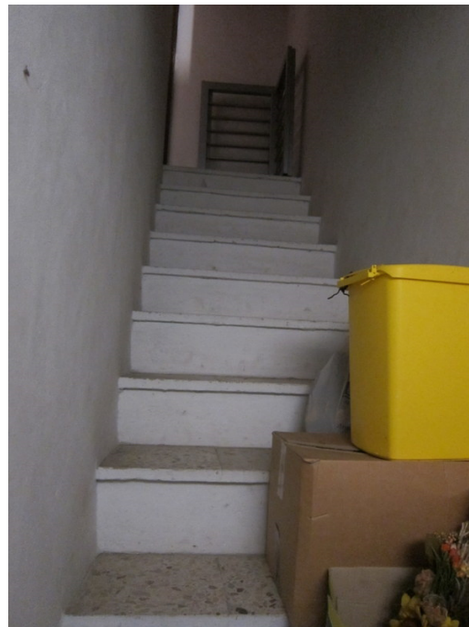
6. Rampa tra piano terra e piano primo
