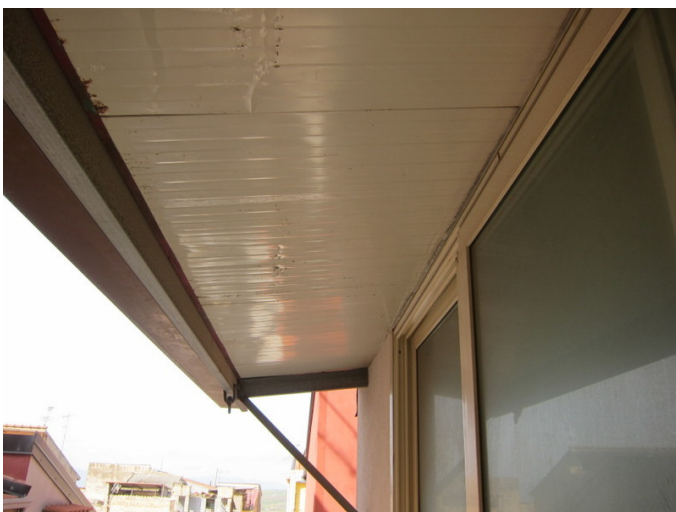
19. Tettoia sul balcone. Piano secondo
