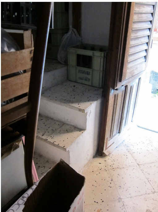
5. Gradini di collegamento col vano scala
