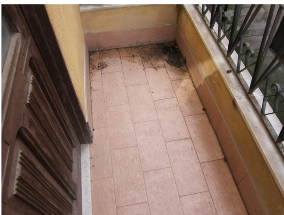
12. Balcone al primo piano
