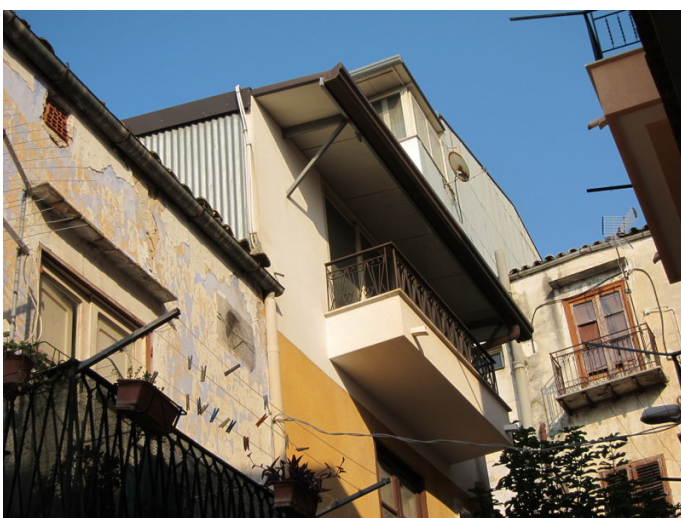
18. Pareti perimetrali piano secondo
