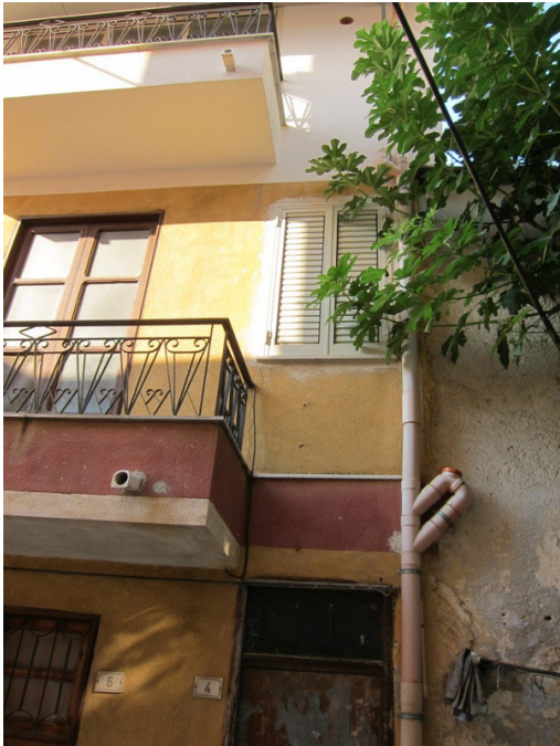
7.8. Finestra del vano scala
