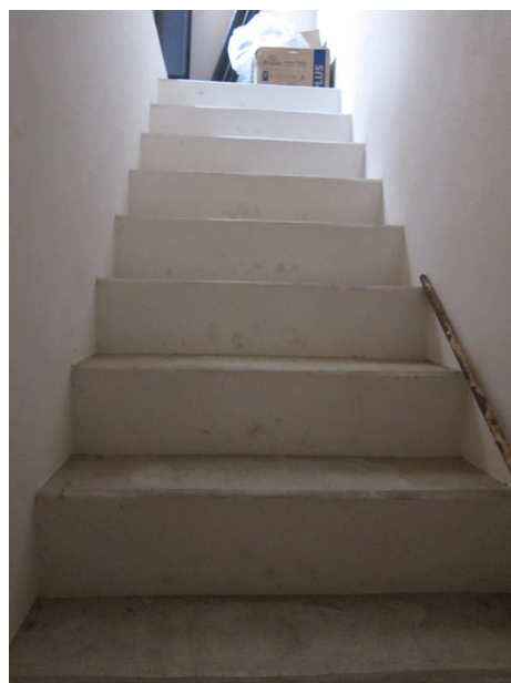
13. Rampa tra piano primo e secondo
