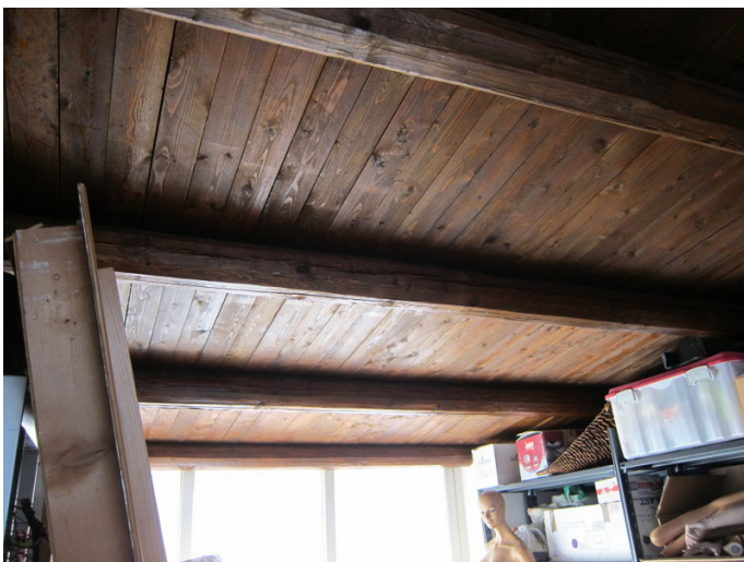
17. Vano 3. Solaio di copertura
