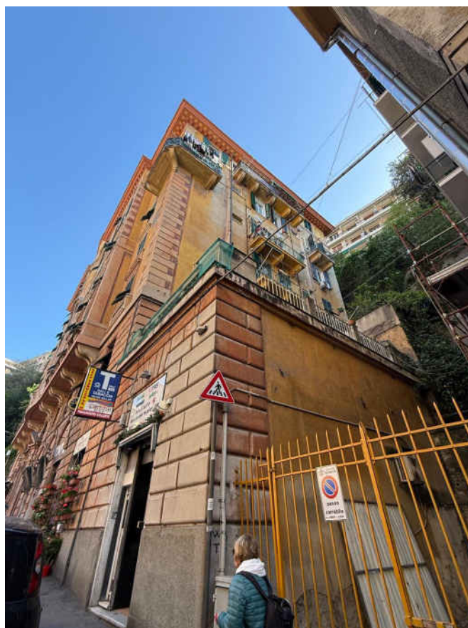
Foto n. 3- Edificio civico 21 di via Venezia, facciate angolo sud-ovest
