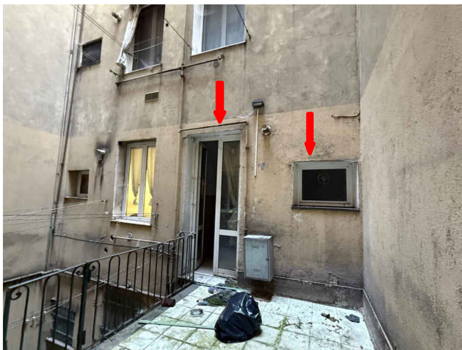
Foto n.21- Terrazzo di pertinenza ricavato nel cavedio interno all'edificio. In evidenza la porta finestra della cucina e il finestrino del bagno. A sinistra la ringhiera del terrazzo con cancelletto per accesso alla porzione condominiale (servitù di passo a favore del condominio).
