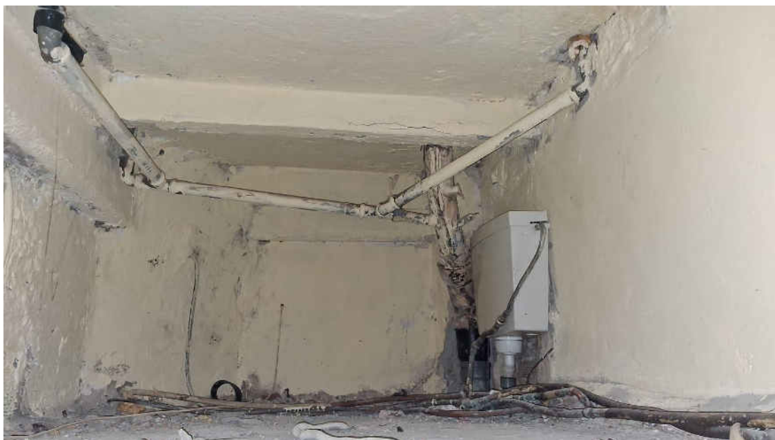
Foto n.34- Vano soppalco sopra al bagno.
