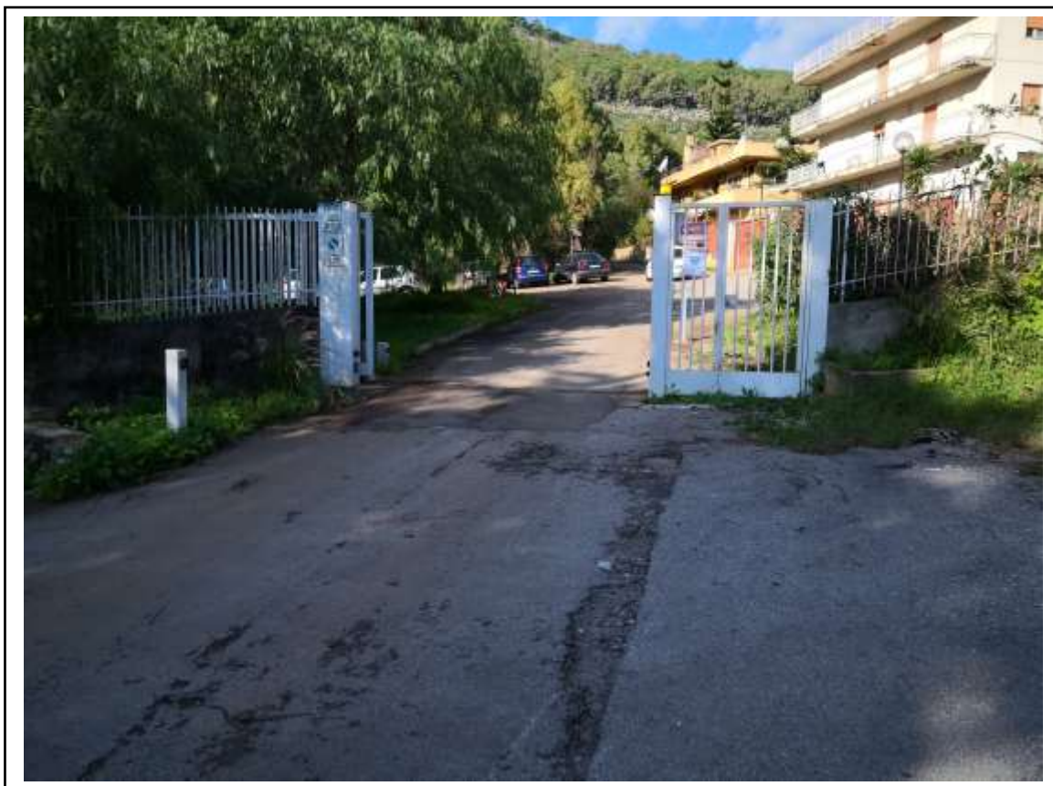
Foto n. 1 – Vista da via Falconara del cancello di accesso (civico n. 58) al complesso Falconarossa e di un tratto della viabilità interna (Via Bellavista)
