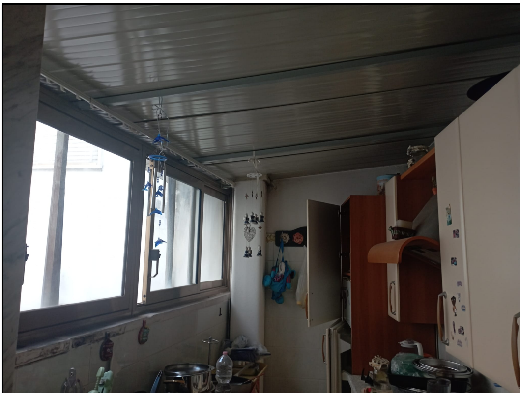
FOTO N°9(pannelli da rimuovere al piano 1°)
